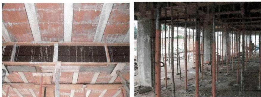
Figura 14 - Fôrmas e escoramentos para lajes e vigas
