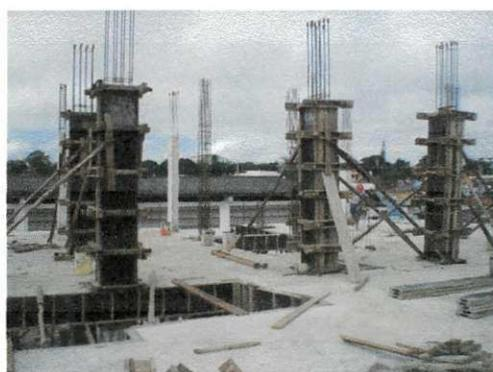
Figura 7 - Armadura à espera do concreto
