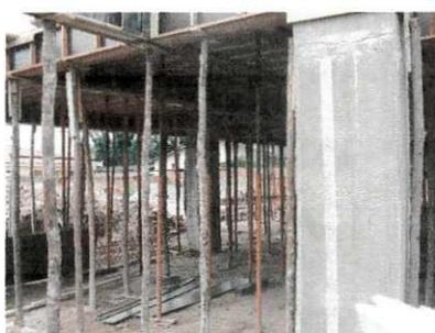
Figura 16 - Pilar depois de retirada a fôrma
