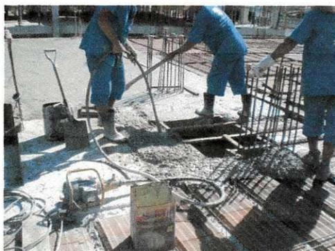
Figura 17 - Vibrador de imersão
