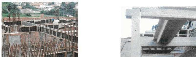
Figura 2 - Operação de montagem de painéis pré-fabricados
