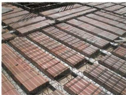
Figura 4 - Laje pré-fabricada antes da concretagem
