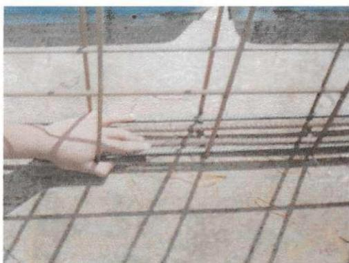
Figura 6 - Verificação dos espaçamentos das ferragens
