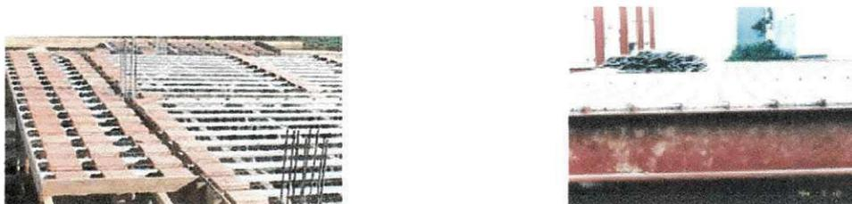
Figura 1 - Operação de alinhamento das vigotas e painéis treliçados
