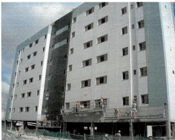
Figura 6.5.2.1 – Execução de Revestimento Externo.
