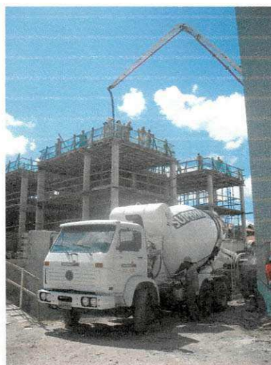
Figura 6.5.2.6 – Concreto Bombeado.
