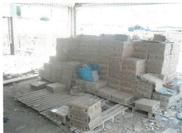
Figura 6.5.2.4 – Armazenamento da Cerâmica.
