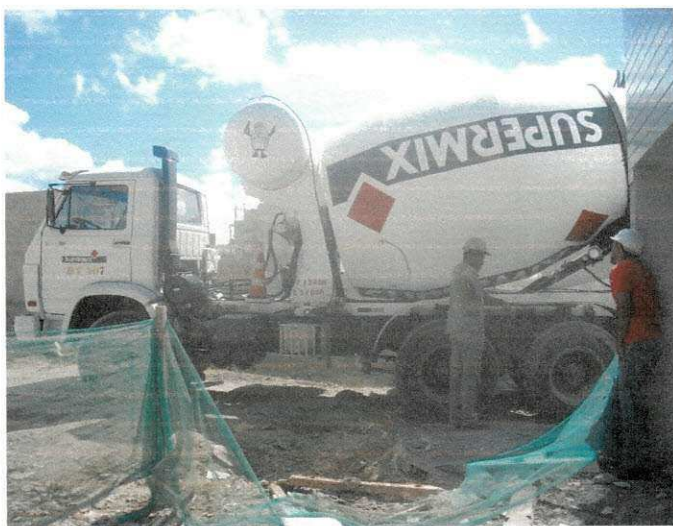
Figura 6.5.2.8 – Caminhão Betoneira da Empresa Supermix.
