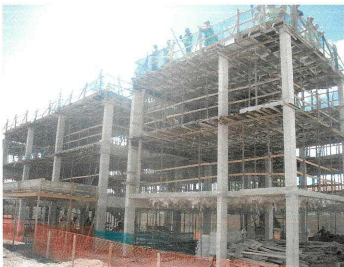
Figura 6.5.2.5 – Concretagem Estrutural.
