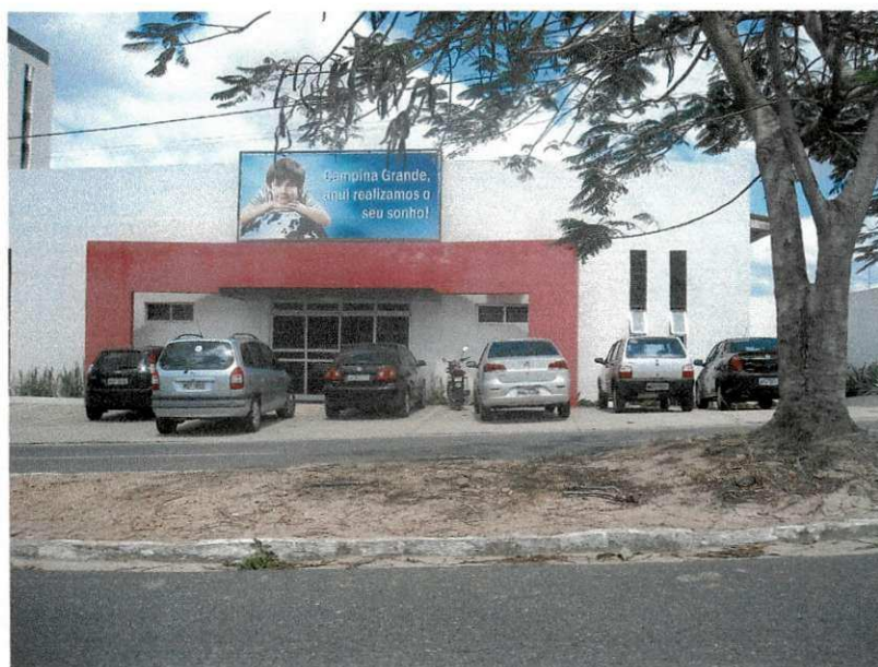
Figura 6.5.1 - Escritório Central da Cipresa Empreendimentos Ltda.
