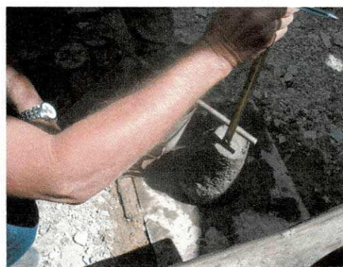
Figura 6.5.2.10 – Medição da Baixa do Concreto.
