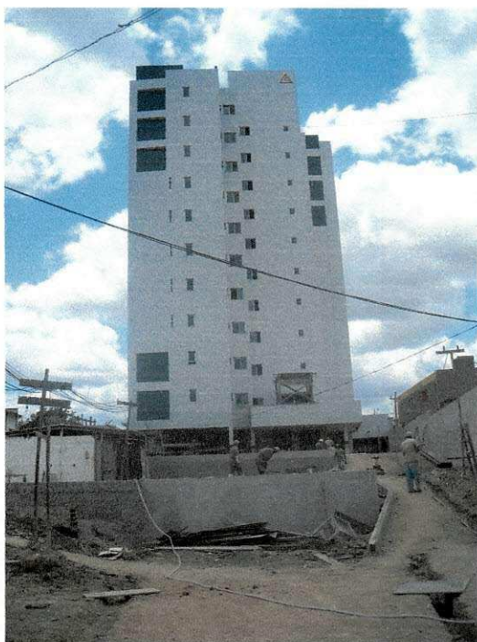
Figura 6.5.1.1 – Concretagem do Muro de Arrimo.
