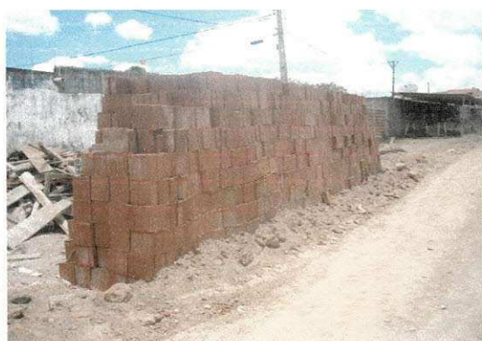
Figura 6.5.2.11 – Armazenamento de Tijolos.
