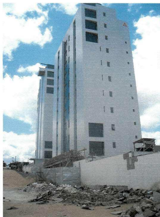
Figura 6.5.1.2 – Acompanhamento do Revestimento.
