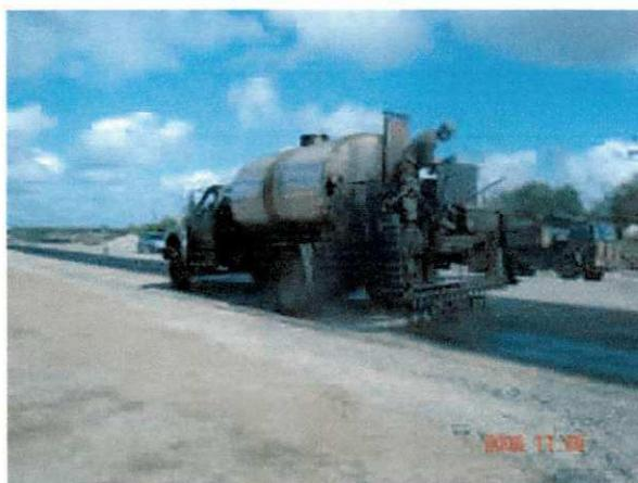
Figura 3.1 Exemplo de aplicação de imprimação.
