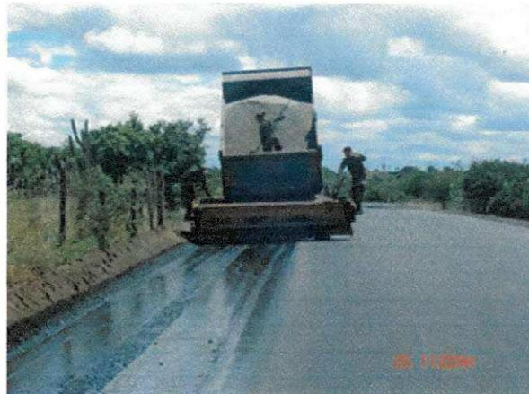
Figura 3.9 Exemplo de distribuição da 1ª camada de agregado.
