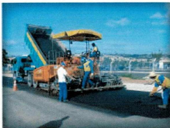
Figura 3.2 Exemplo de lançamento de C.B.U.Q. em vibroacabadora.
