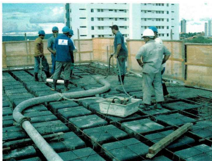
Figura 4.9- Adensamento do concreto
