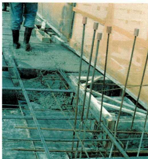
Figura 4.11- Concretagem de vigas
