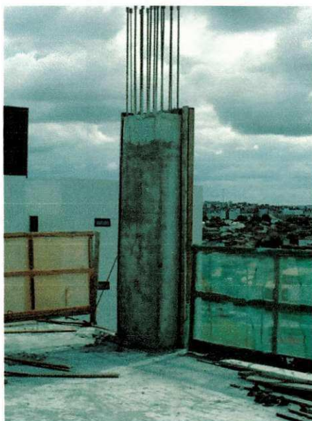
Figura 4.10 – Remoção da fôrma do pilar
