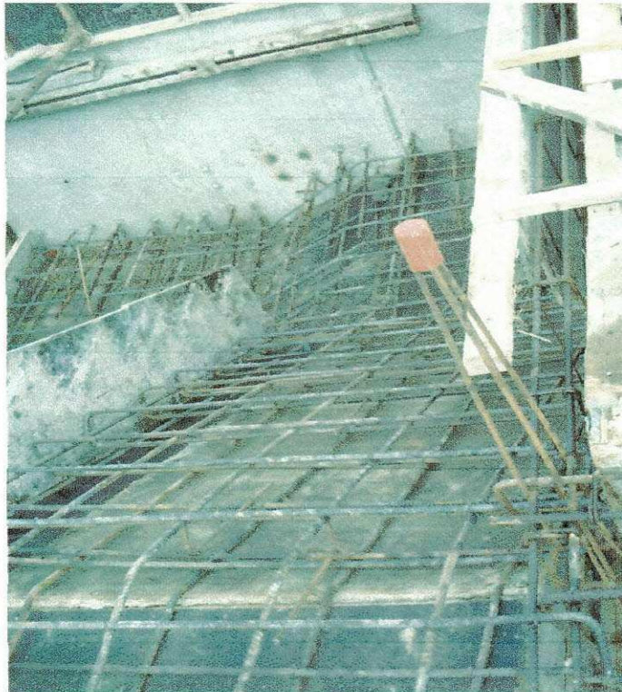
Figura 4.15 – Execução de uma escada
