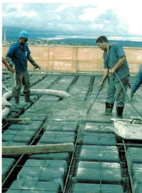
Figura 4.12- Transporte de concreto
