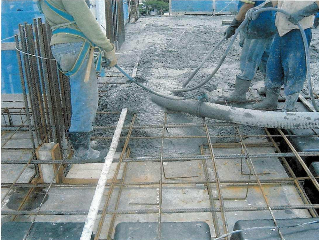
Foto 07 – Adensamento com vibrador de imersão
