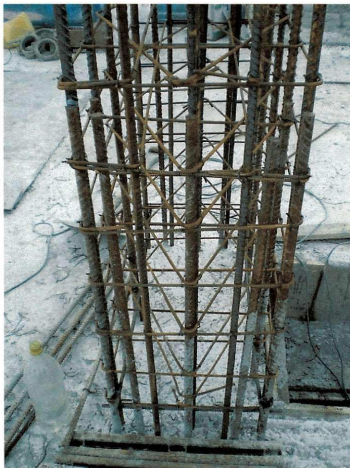
Fotos 10– Detalhe da armadura em losango
