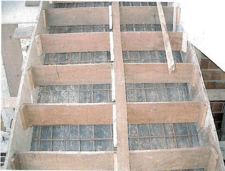
Foto 20 – Formas da escada
