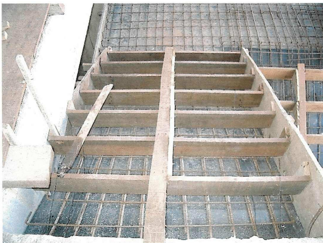
Foto 23 – Formas e ferragens das escadas
