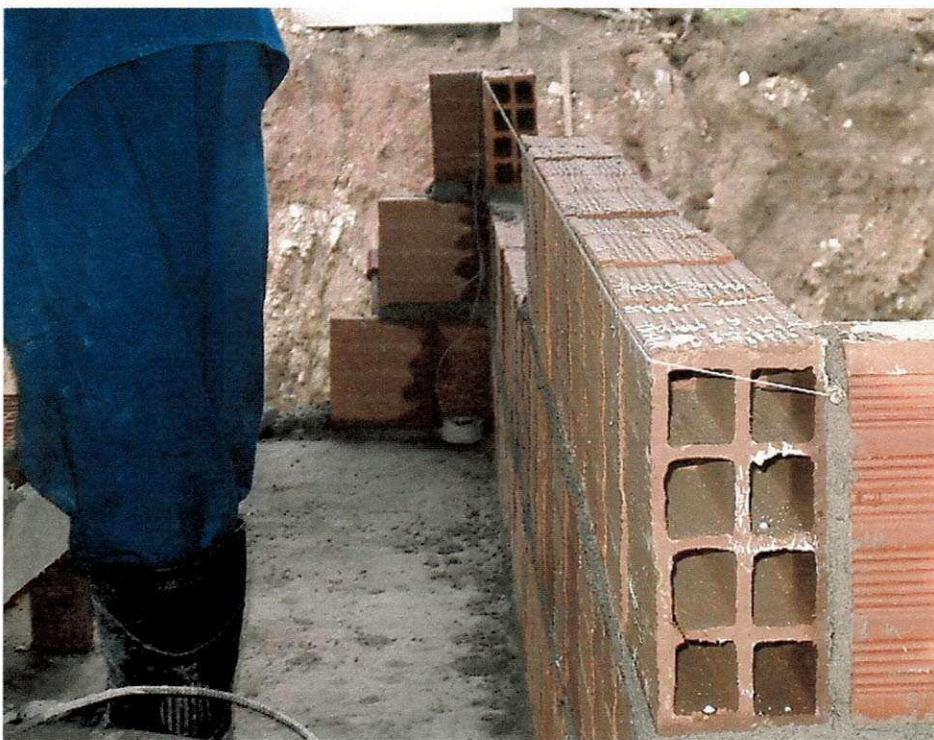
Foto 25 – Alvenaria de tijolos
