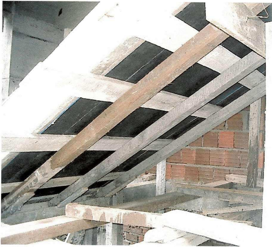
Foto 19 – Formas da escada
