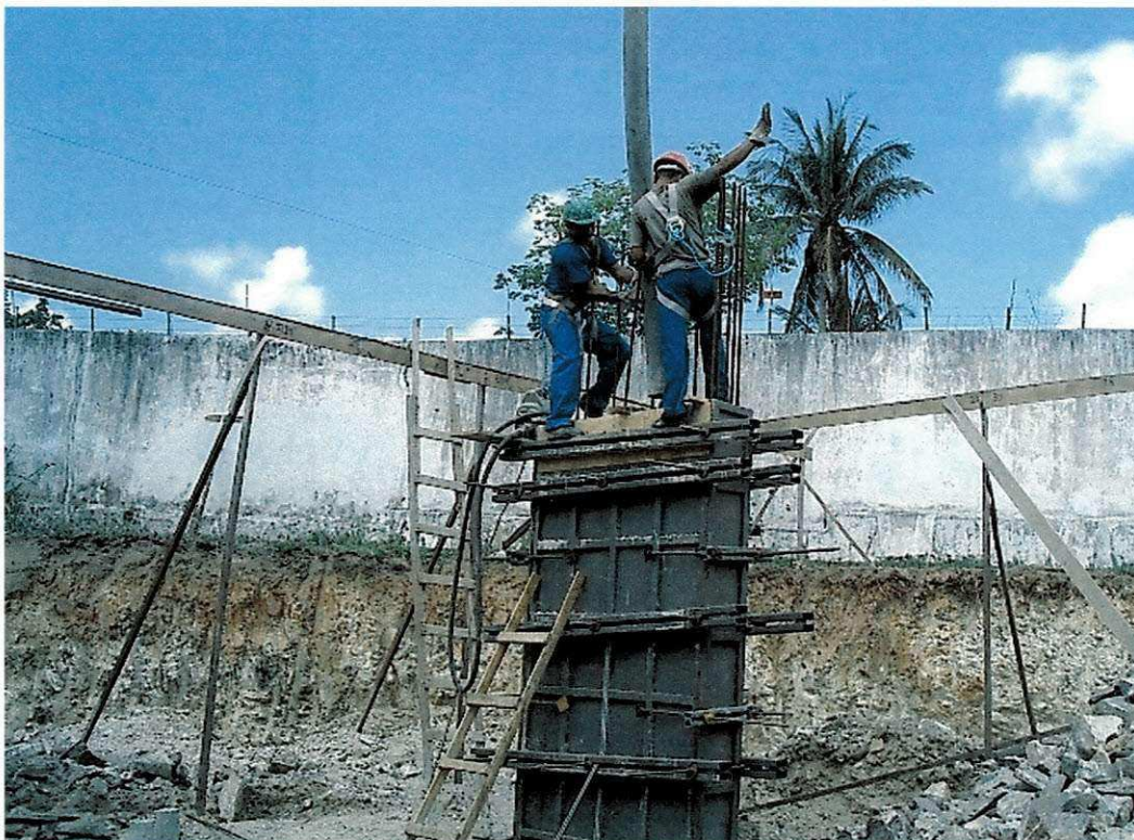
Foto 05 – Lançamento feito com utilização de bomba
