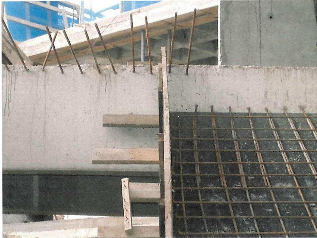
Foto 21 – Ferragens da escada
