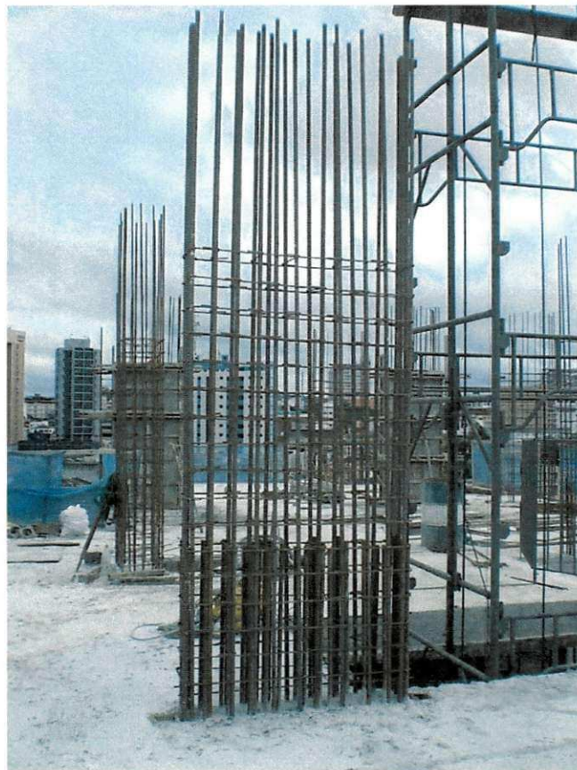
Foto 9– Detalhe das armaduras dos pilares
