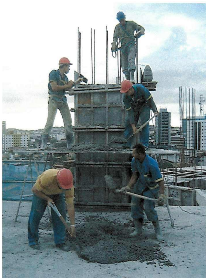
Foto 06 – Lançamento feito através de pás
