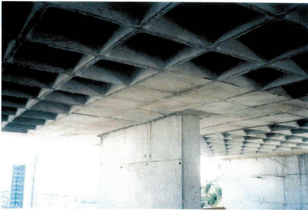
Foto 17 – Detalhe mais aproximado da laje maciça no encontro com o pilar
