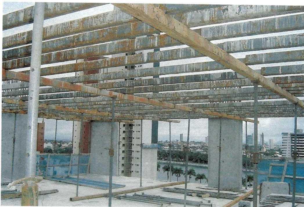
Foto 11 - forma metálica montada
