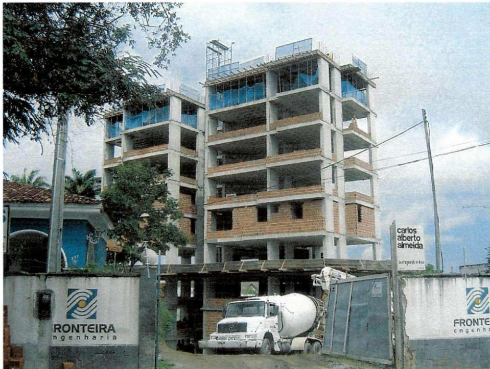
Foto 01 – Residencial em construção
