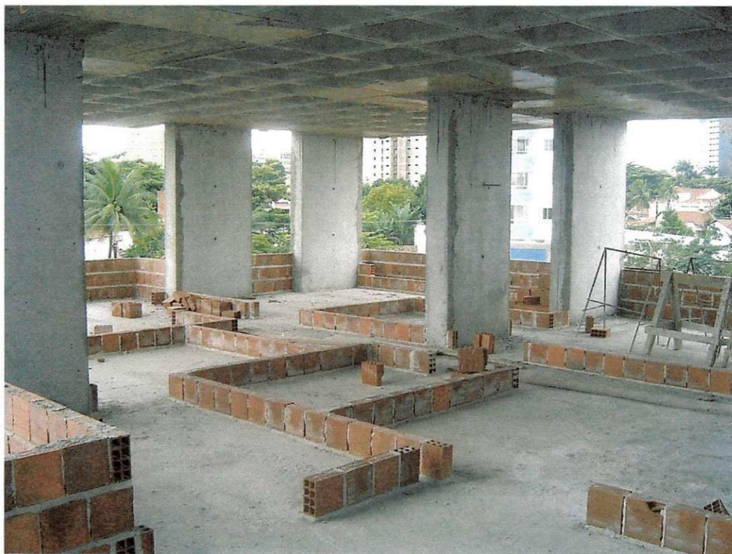
Foto 29 – Demarcação da alvenaria
