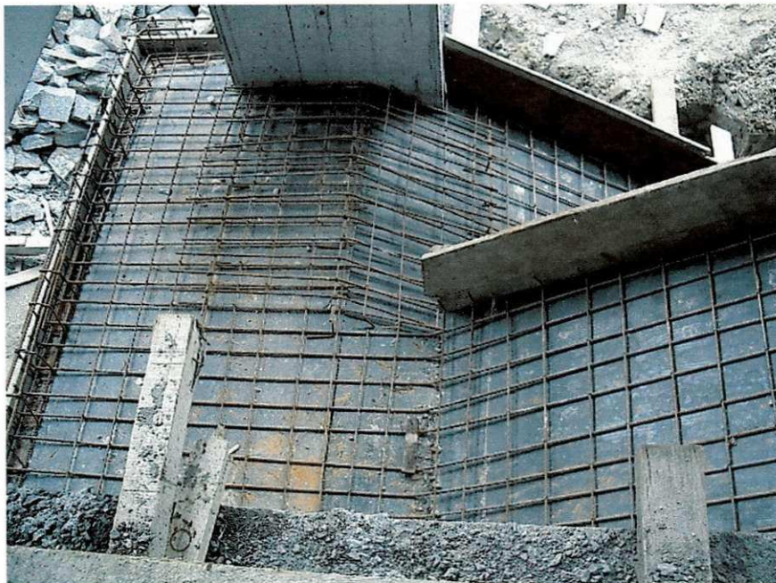
Foto 22 – Ferragens da escada
