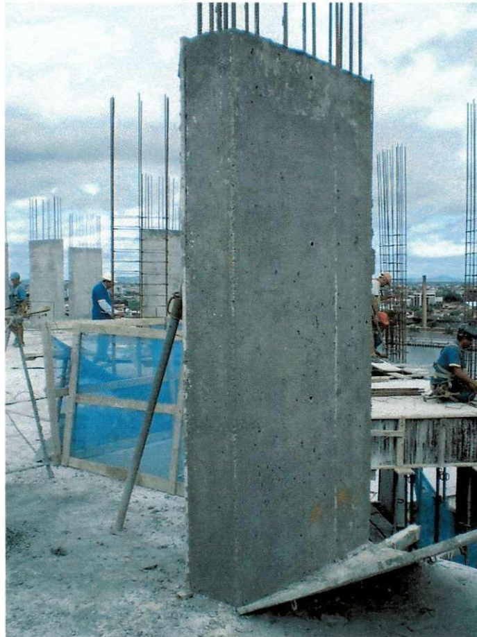
Foto 08 – Detalhe das dimensões do pilar
