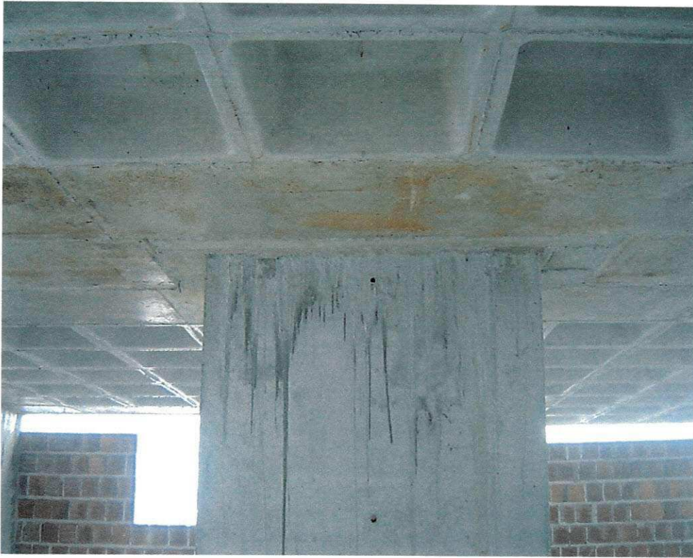
Foto 16– Detalhe para a laje maciça no encontro com o pilar
