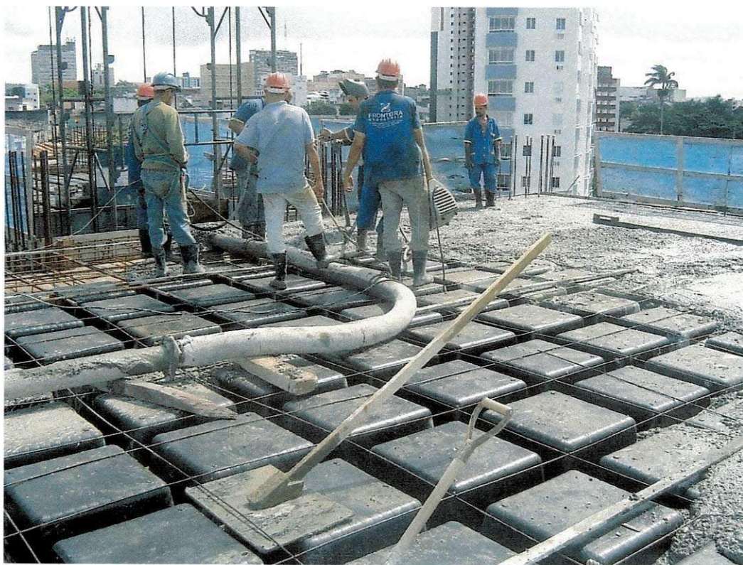
Foto 03 – Transporte feito por bombeamento
