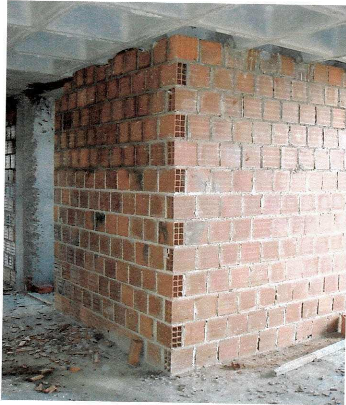
Foto 30 – Ligação entre as alvenarias
