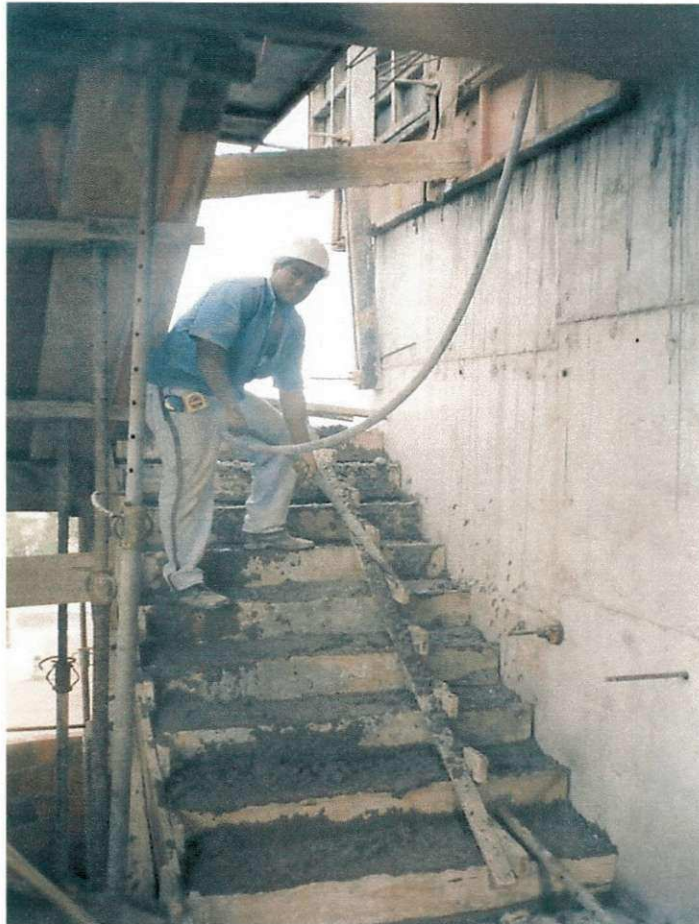
Foto 24 – Concretagem da escada e adensamento com vibrador de imersão
