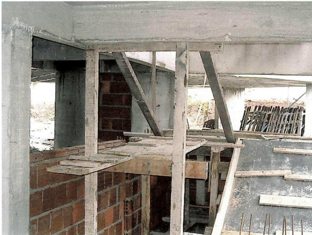
Foto 18 – Formas da escada
