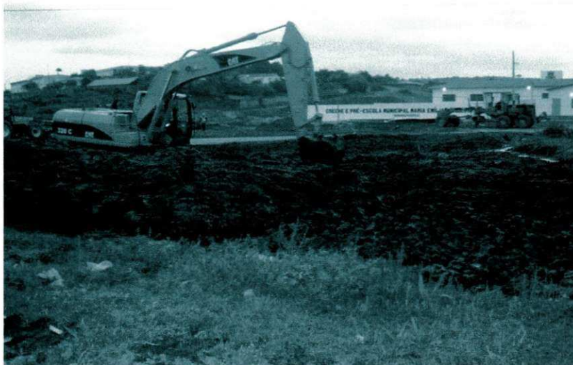
Foto 1 – Fonte Direta: Movimento de terra
