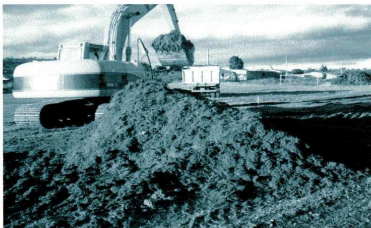
Foto 2 – Fonte Direta: Movimento de terra (bota-fora).
