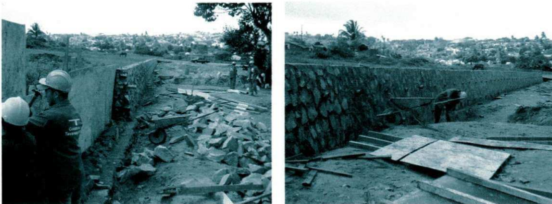
Foto 5 e 6 – Fonte Direta: Muros de Arrimo
