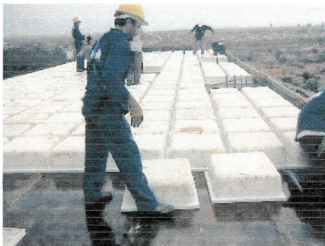
Figura 16 - Colocação das fôrmas no tablado
