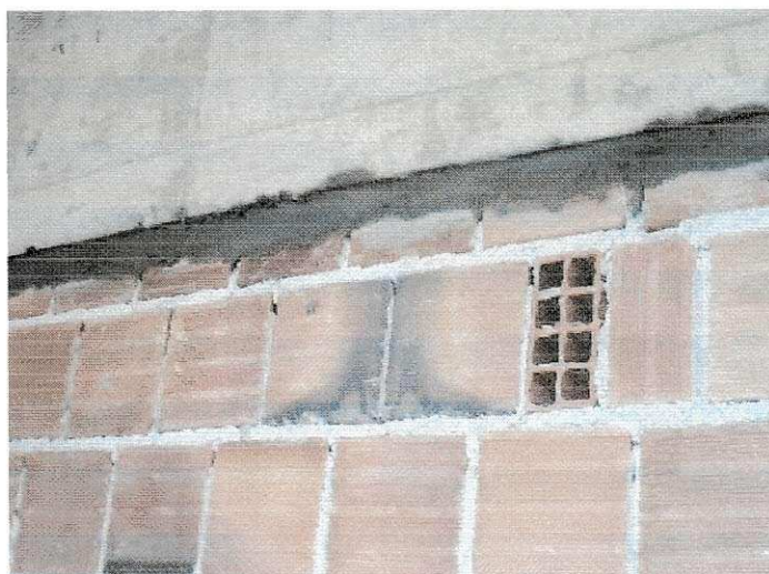
Figura 7 – Detalhe do encunhamento
