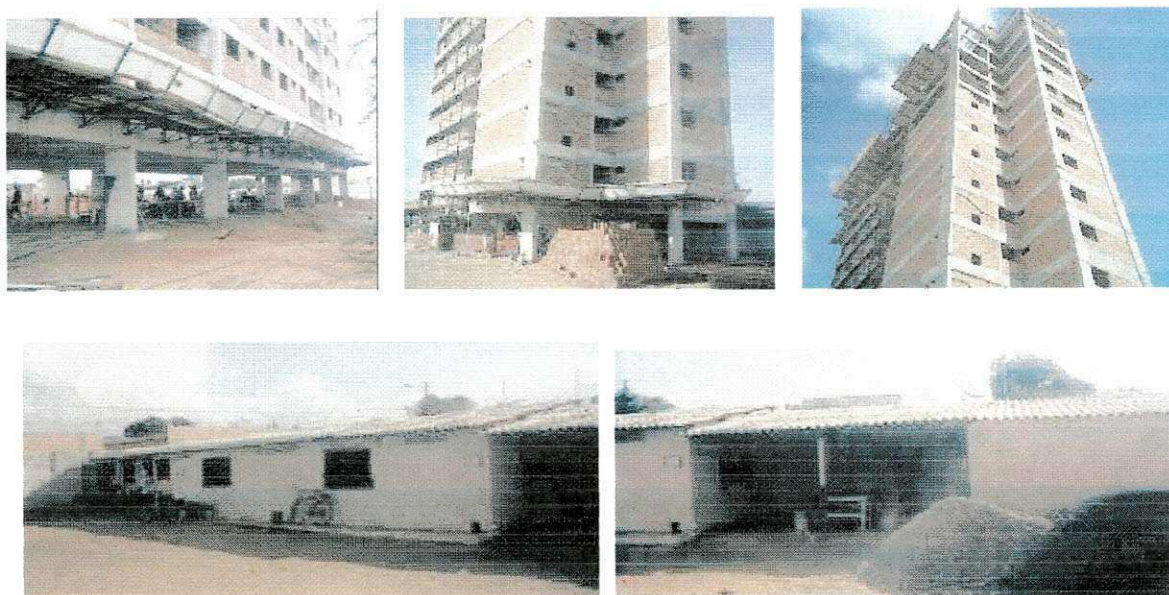
Figura 3- Canteiro de obras
