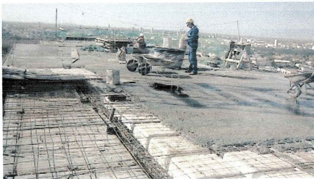
Figura 18 - Concretagem da última laje (a esquerda detalhe da parte maciça)
