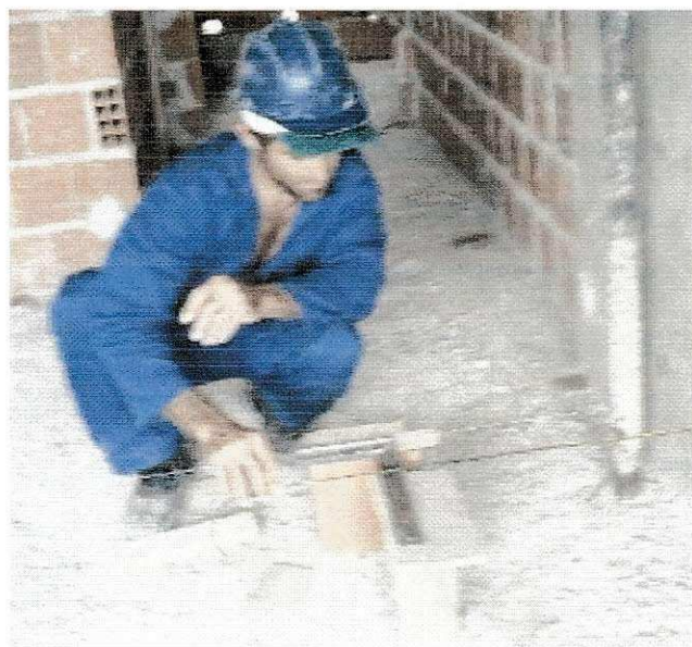
Figura 8.1 – Verificação do emestramento
