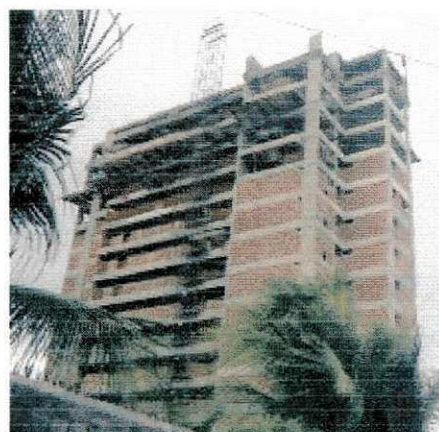
Figura 2 - Residencial Antônio do Rosário em construção
