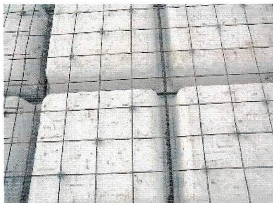
Figura 17 -Detalhe dos espaçadores na armadura
