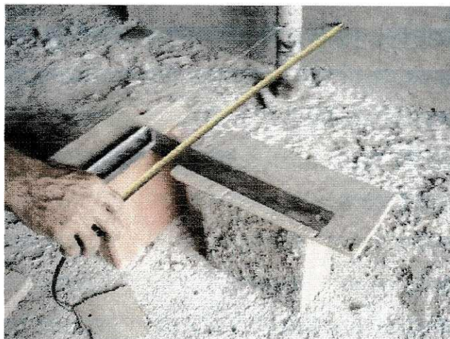
Figura 8.2 – Verificação do emestramento
