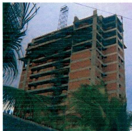
Figura 2 - Residencial Antônio do Rosário em construção
