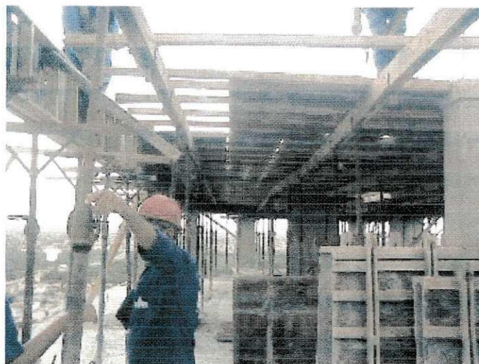
Figura 14 - Execução do tablado
