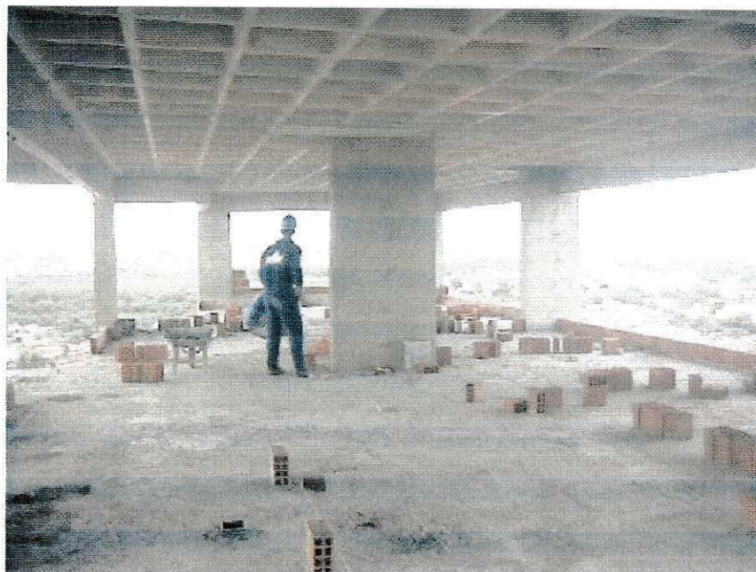
Figura 4 - Marcação e assentamento da 1ª fiada
