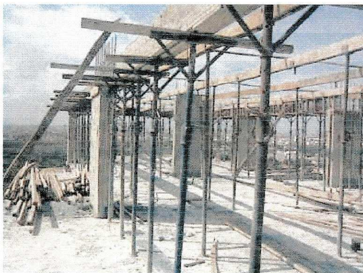
Figura 13 - Pilares / Escoramento (15º pavimento)
