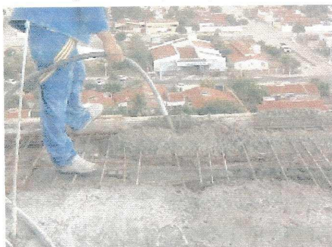
Figura 19 - Adensamento com uso do vibrador
