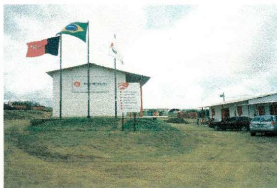
FOTO 04 - Instalação do canteiro de obras-vista "B"
