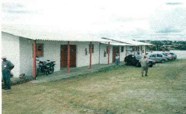
FOTO 03 - Instalação do canteiro de obras-vista "A"
