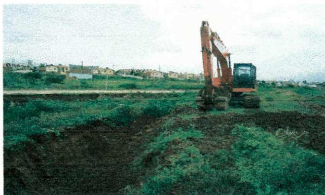
FOTO 07 - Escavação mecânica em terra até 2,0 m
