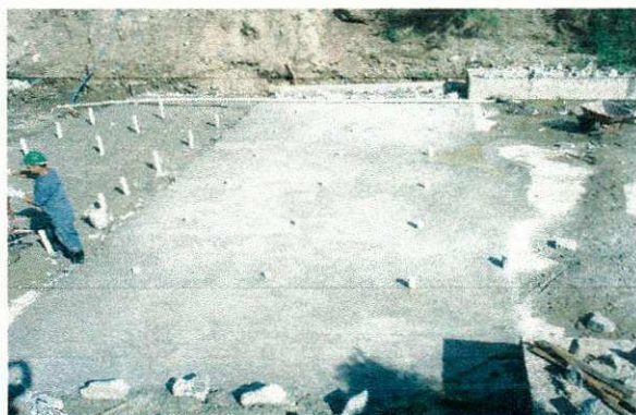
FOTO 12 - Fundo do canal em concreto ciclópico - vista "A"
