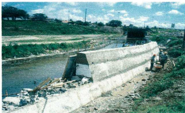
FOTO 14 - Paredes do canal em concreto ciclópico
