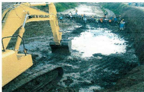
FOTO 06 - Escavação mecânica em lama-vista "B"
