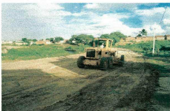
FOTO 01 - Desmatamento, destocamento e limpeza-vista "A"
