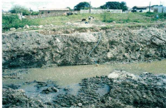
FOTO 08 - Esgotamento de vala
