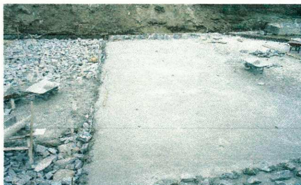
FOTO 13 - Fundo do canal em concreto ciclópico - vista "B"
