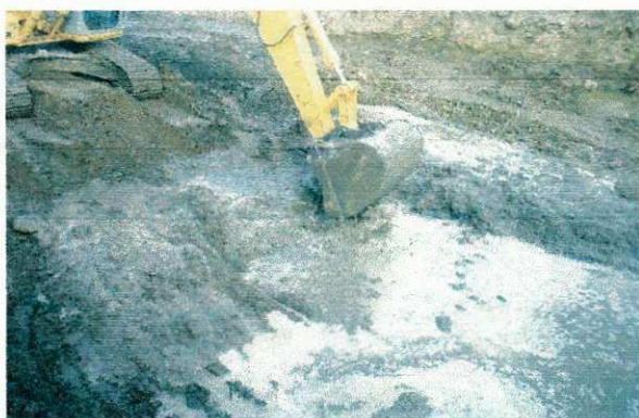
FOTO 05 - Escavação mecânica em lama-vista "A"
