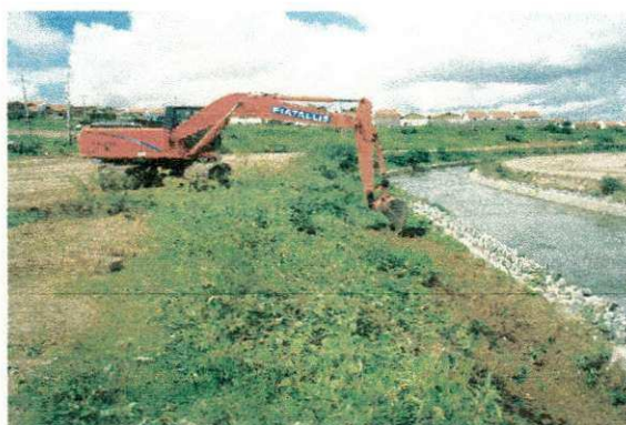
FOTO 02 - Desmatamento, destocamento e limpeza-vista "B"
