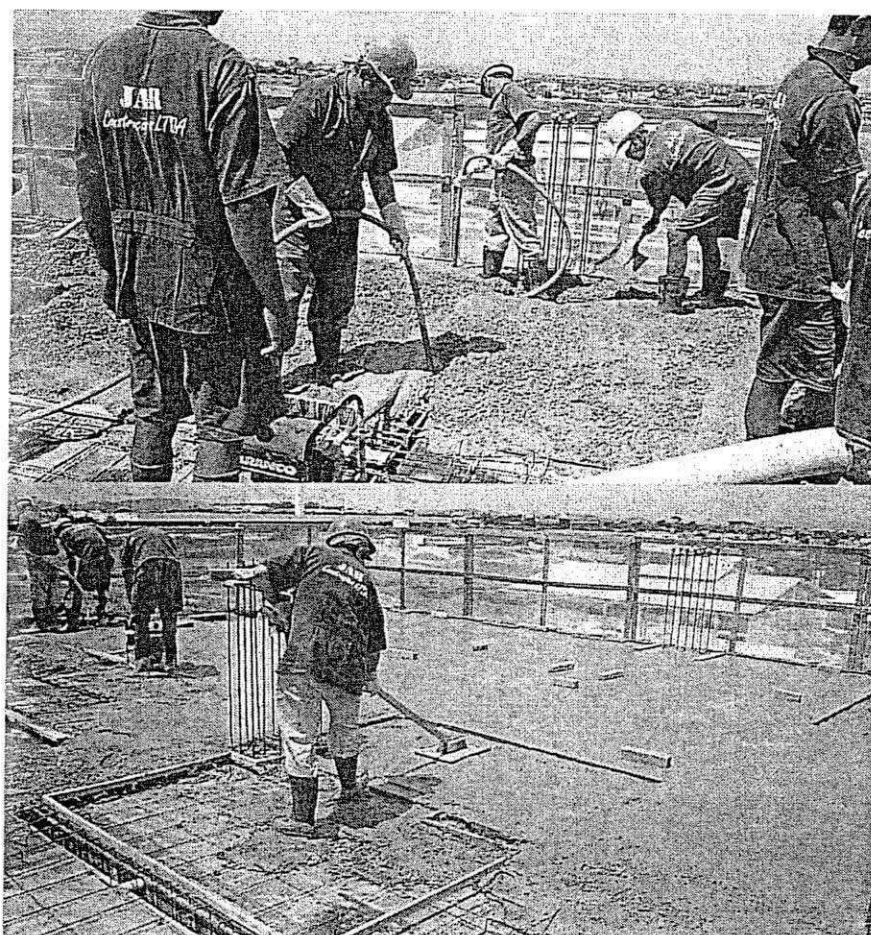
Figura 9. Concretagem de lajes e vigas (Pinheiro, 2006).
