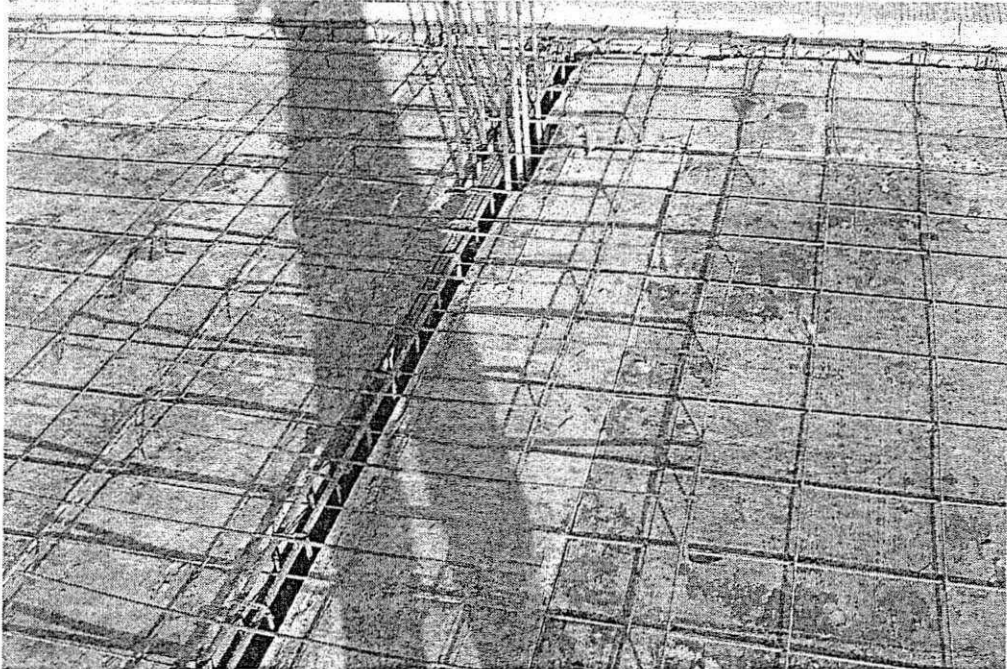
Figura 2. Distribuição do aço no encontro de duas lajes
