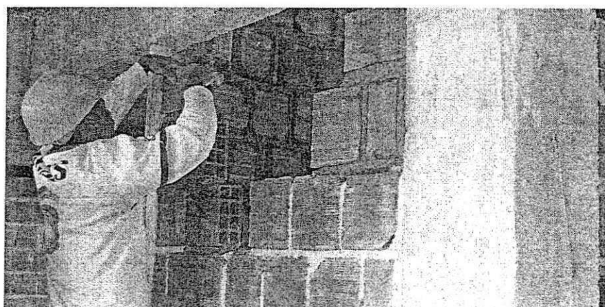
Figura 12. Detalhes dos processos de marcação (A) e levantamento de alvenaria (B).
