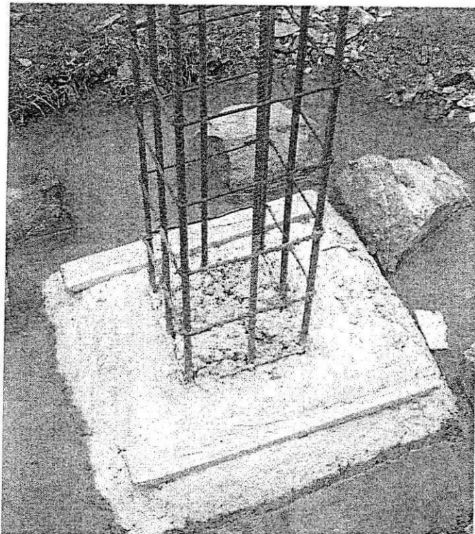
Figura 11. Sapata isolada com armadura de espera para moldagem do pilar
