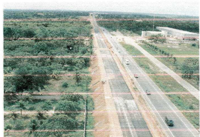
Figura 15 – CCR lançado e imprimado
