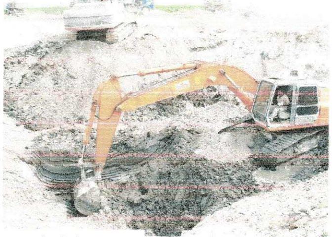
Figura 11 – Remoção de Solo Mole
