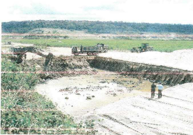
Figura 11 – Remoção de Solo Mole
