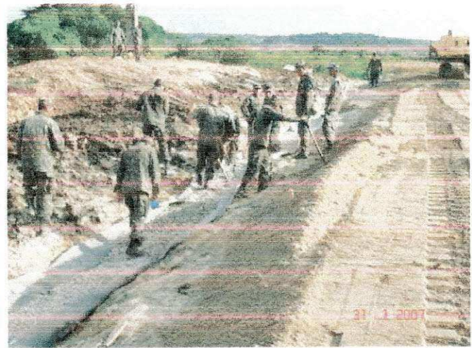
Figura 13 – Aplicação de Geodreno e Geogrelha
