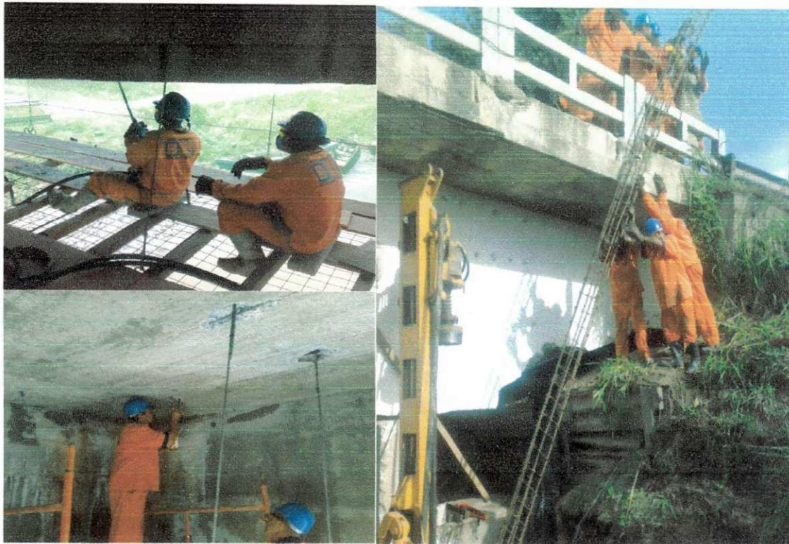
Figura 26 – Execução dos serviços na Ponte sobre o Canal de Goiana.
