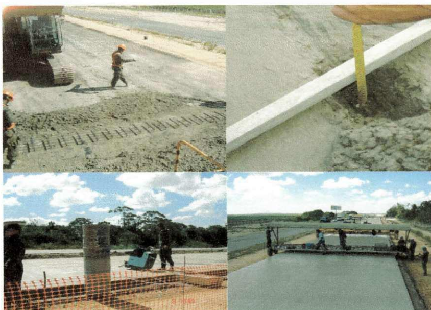
Figura 30 – Execução da camada de Concreto simples – (CS)
