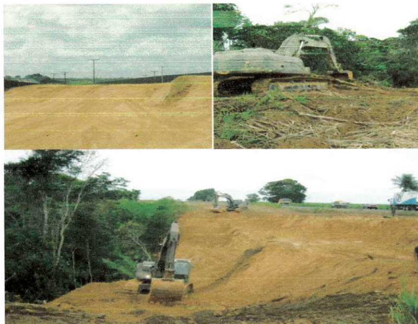
Figura 28 – Execução dos serviços de Terraplenagem.
