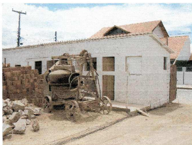
Fotos 5: Entrada do terreno e vista do almoxarifado
