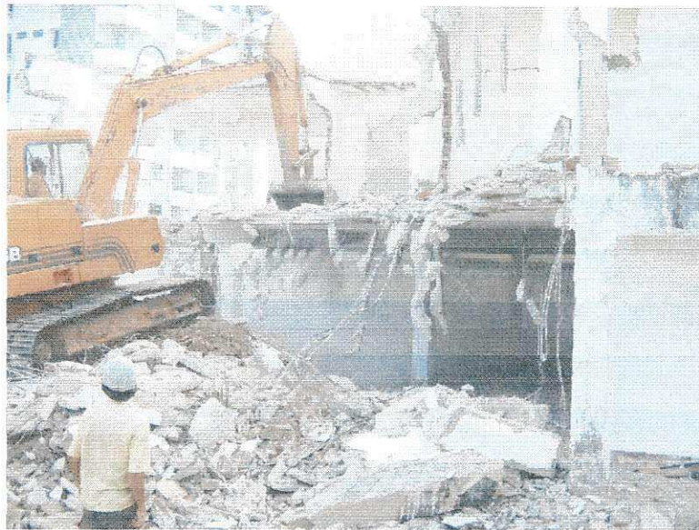
Foto 1: Detalhe da retroescavadeira durante a demolição
