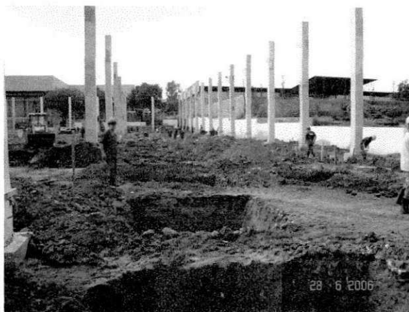
Foto 06 – Sapatas do Prédio 3
