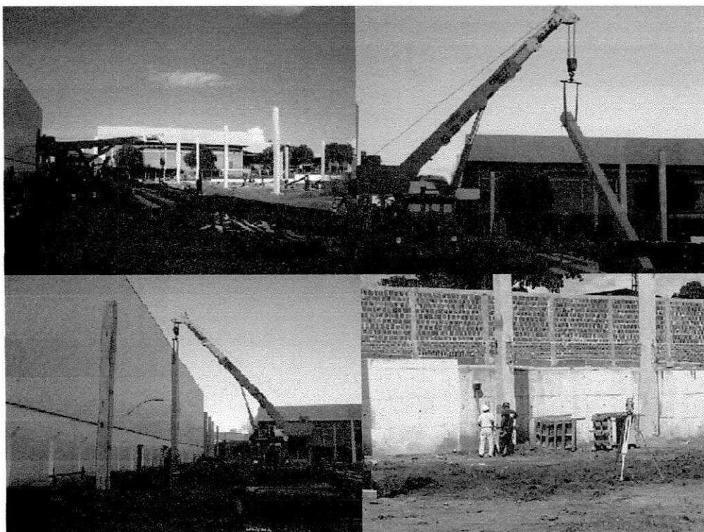
Foto 14 – Colocação do Pilar no Cálice da Sapata e Alinhamento
