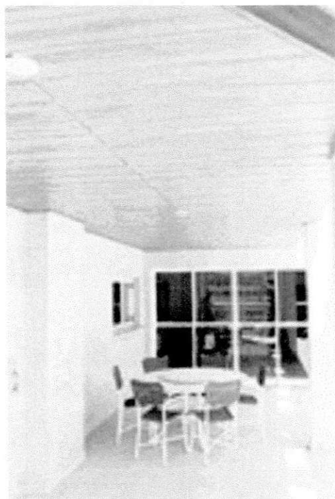
Foto 33 – Forro em Durawall
