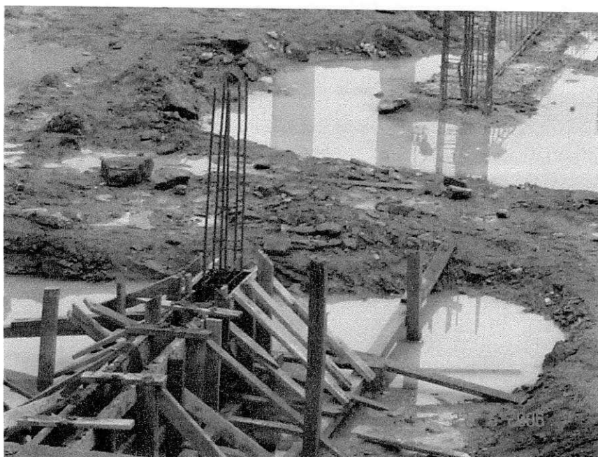
Foto 12 – Armação das Fôrmas das Cintas do Prédio 4
