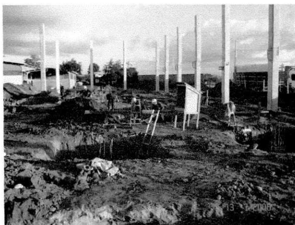
Foto 05 – Sapatas do Prédio 2
