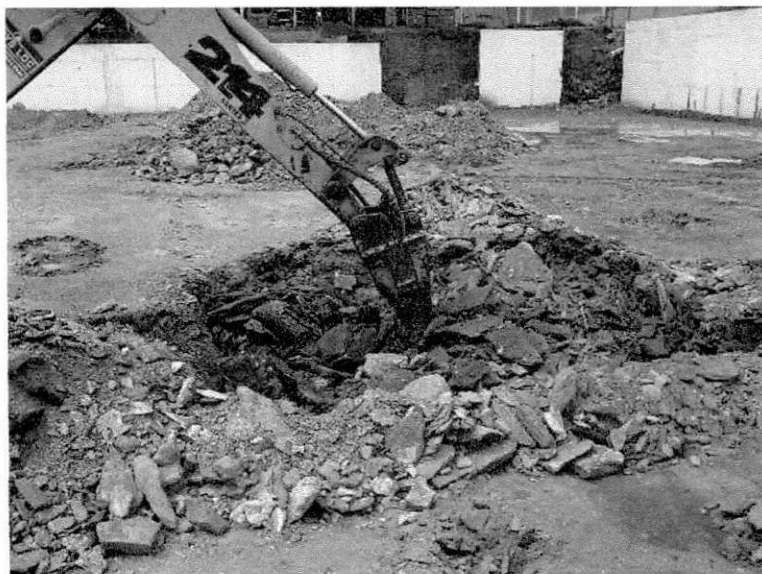
Foto 07 – Escavação das Sapatas do Prédio 4
