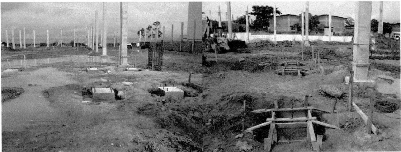
Foto 08 – Bases das Sapatas do Banbury
