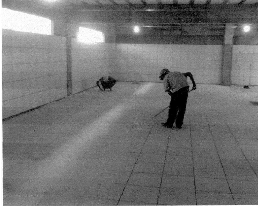
Foto 27 – Revestimento Cerâmico
