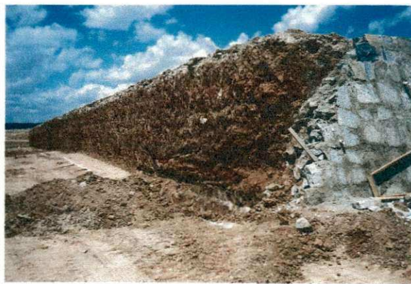
Fig. 5 - Construção do muro de arrimo;
