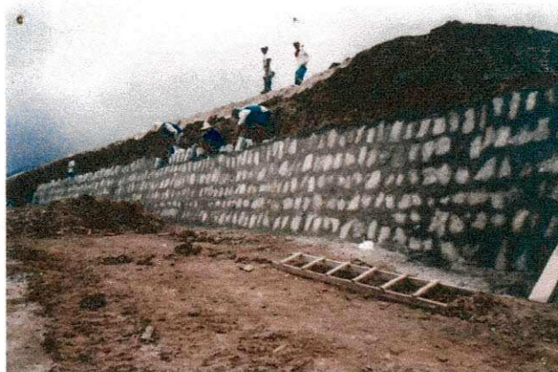
Fig. 6 – Vista frontal do muro de arrimo;
