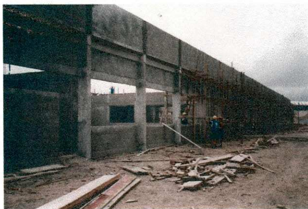
Fig. 7 – Levante dos vigamentos dos Blocos;
