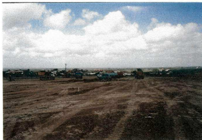
Fig. 1 - Demarcação do terreno;
