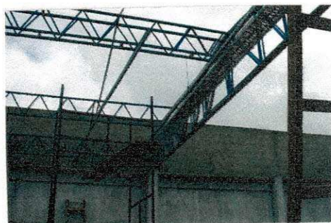
Fig. 12 – vigamentos metálicos no Bloco A;
