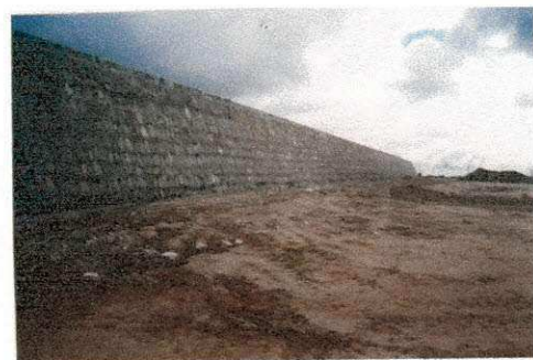
Fig. 13 – Vista da conclusão do muro de arrimo nos Blocos.
