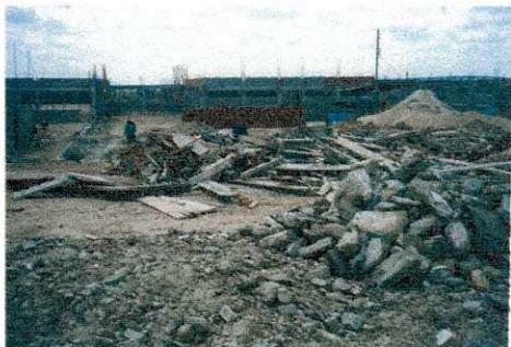
Fig. 10 – fundação e levante das alvenarias;
