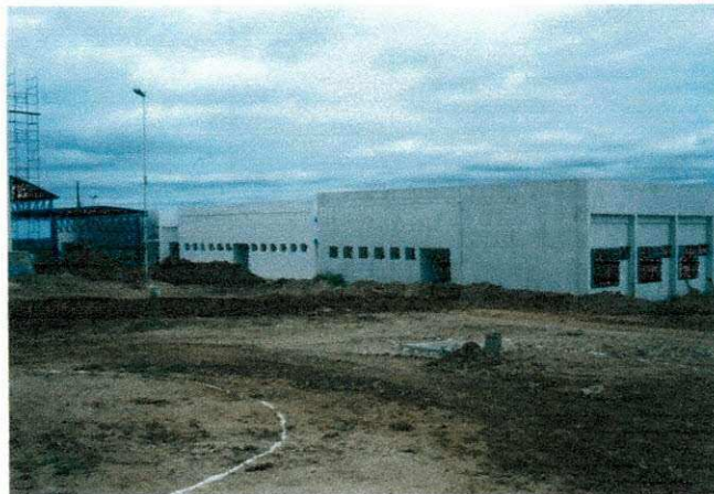
Fig. 9 – Conclusão da alvenaria dos Blocos;
