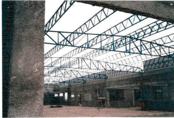
Fig. 8 – Montagem das estruturas metálicas;
