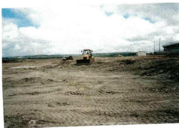
Fig. 2 – Terraplanagem do terreno;
