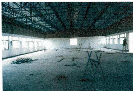
Fig. 11 – Fechamento das estruturas metálicas;
