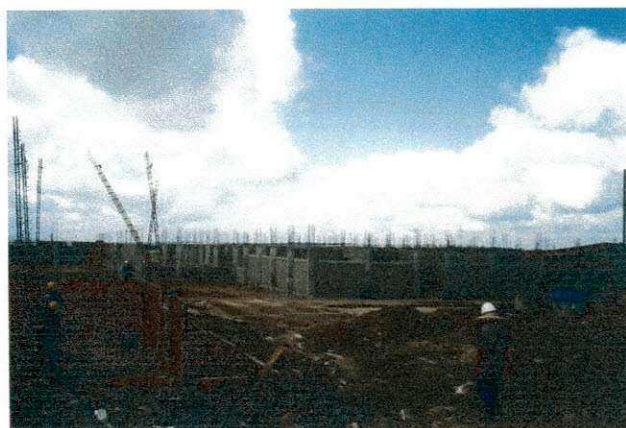
Fig. 3 – Levante das alvenarias;
