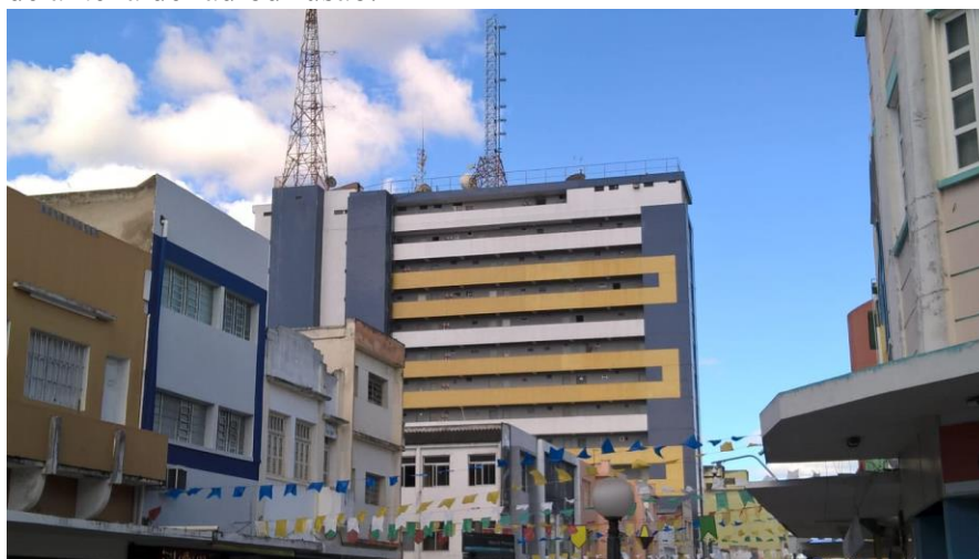
FIGURA 10: Imagem do Ed. Engenheiro Roberto Palomo, ao fundo com torres de antena de radiodifusão.
