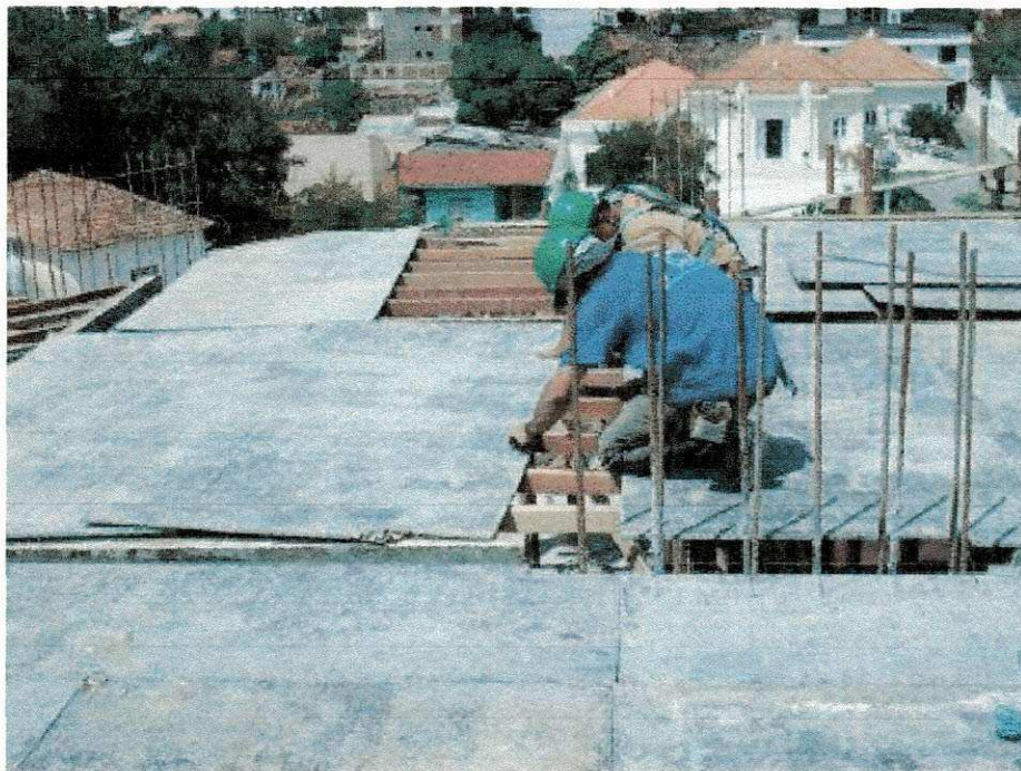
Figura 9 - Montagem de fôrmas para lajes
