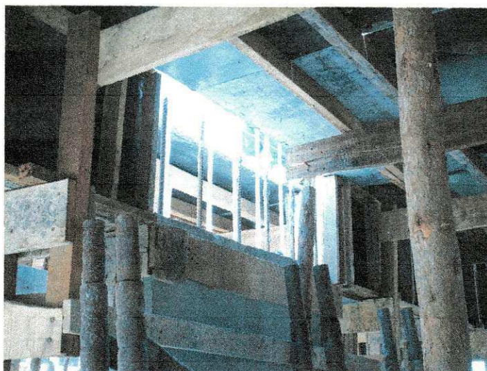
Figura 7 – Encontro do pilar com a viga
