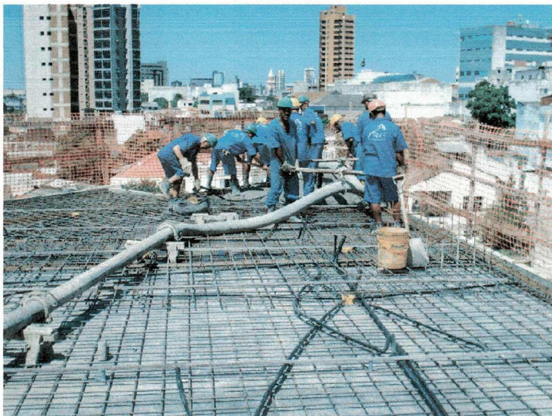
Figura 1- Concretagem das Lajes
