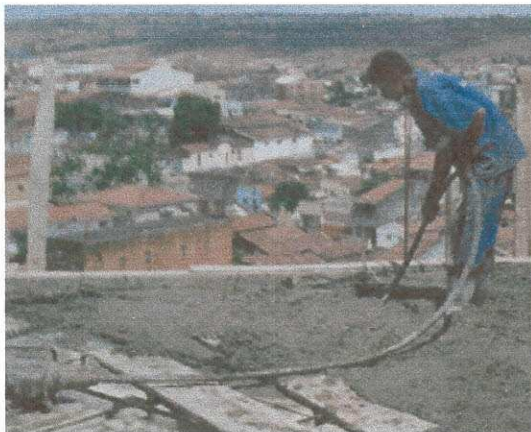
Figura 17: Operário vibrando o concreto.
