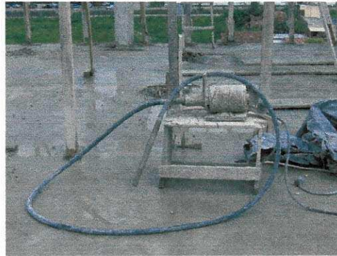
Figura 19: Vibrador por imersão
