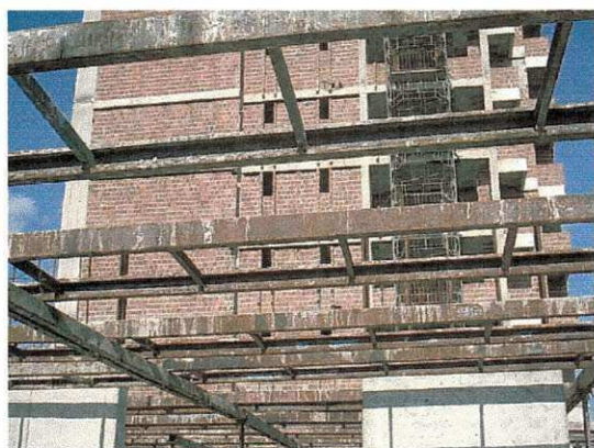
Figura 25: Escoramentos horizontais
