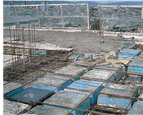
Figura 16: Concretagem da laje
