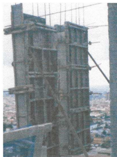
Figura 24: Pilar a espera do concreto
