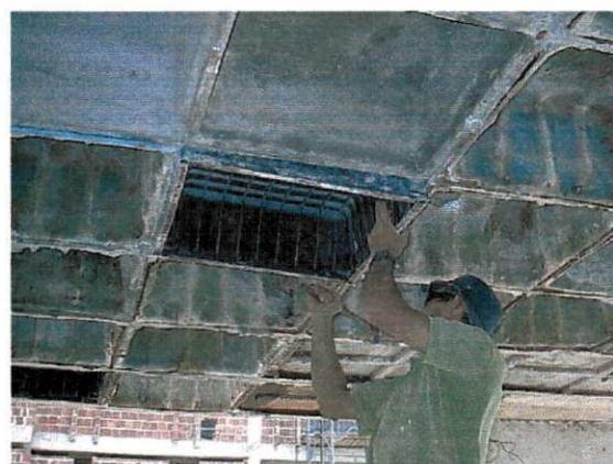
Figura 22: Retirada das fôrmas
