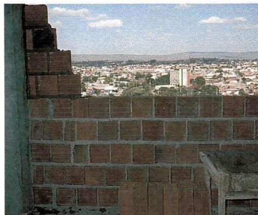
Figura 20: Levantamento da alvenaria
