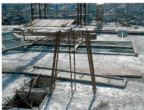
Figura 30: Ferros expostos sem capacete
