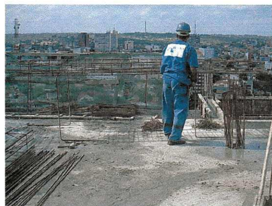
Figura 28: Preparação da armadura do pilar
