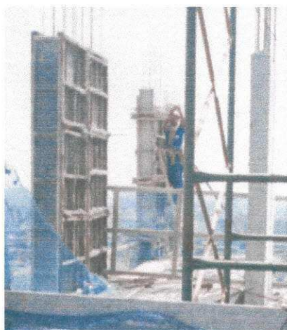
Figura 23: Retirada das fôrmas.
