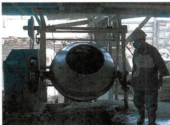
Figura 14: Concreto fabricado com betoneira
