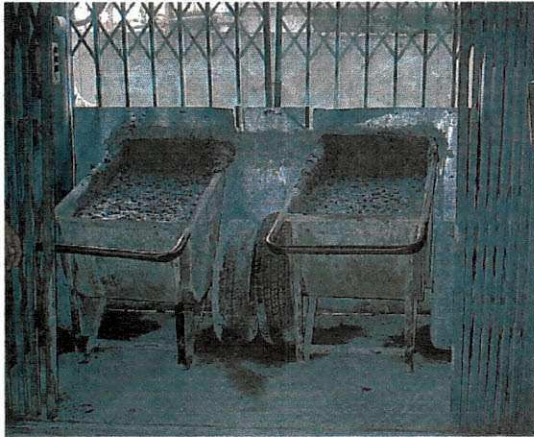
Figura 15: Transporte do concreto
