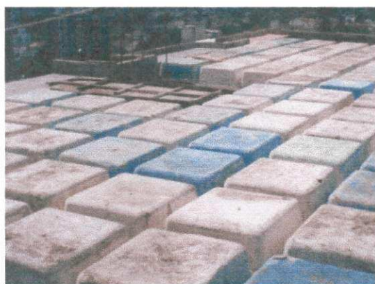
Figura 21: Laje nervurada antes da concretagem.
