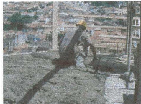
Figura 18: Operário nivelando o concreto.
