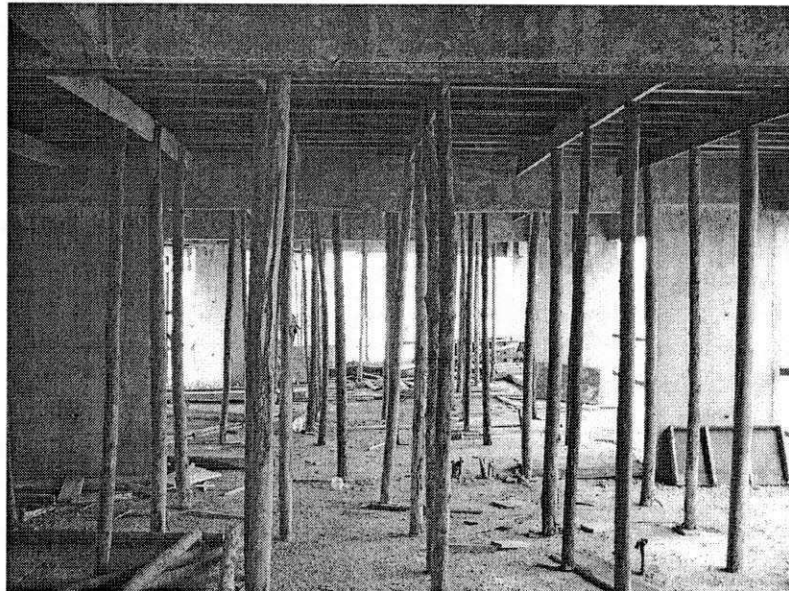
Figura 18 – Estrutura para receber as fôrmas da obra
