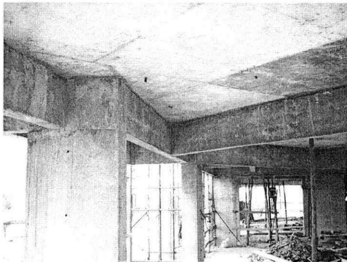
Figura 22 – Laje depois da retirada das Fôrmas
