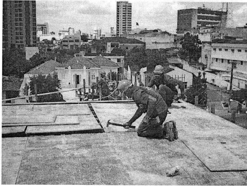
Figura 17 – Colocação das Fôrmas na laje da obra
