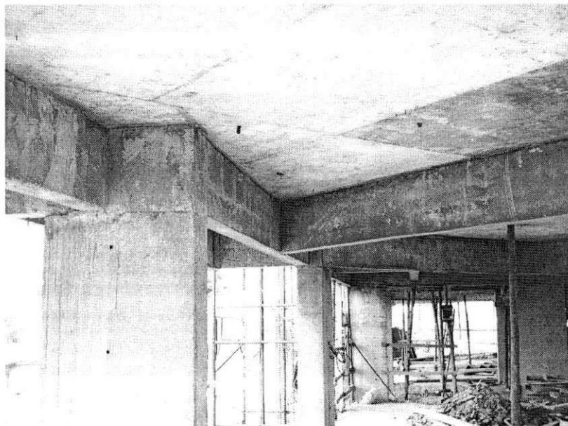
Figura 40 - Encontro da laje maciça com o pilar
