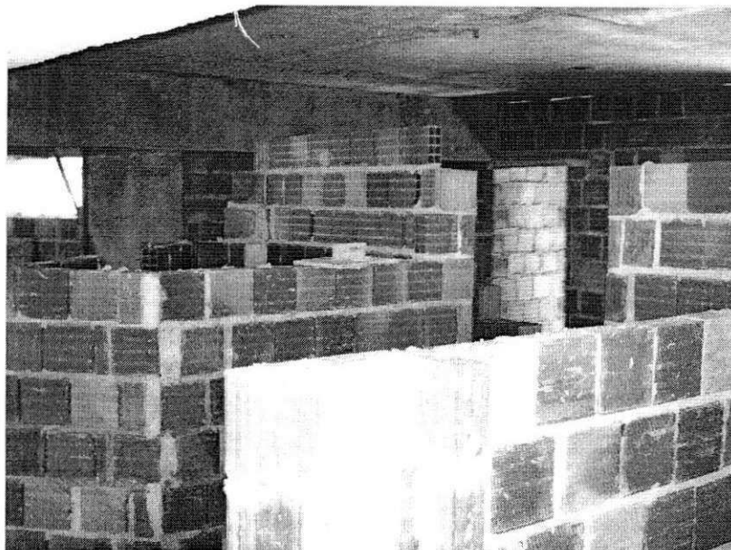
Figura 32 – Alvenaria de tijolos furados da obra
