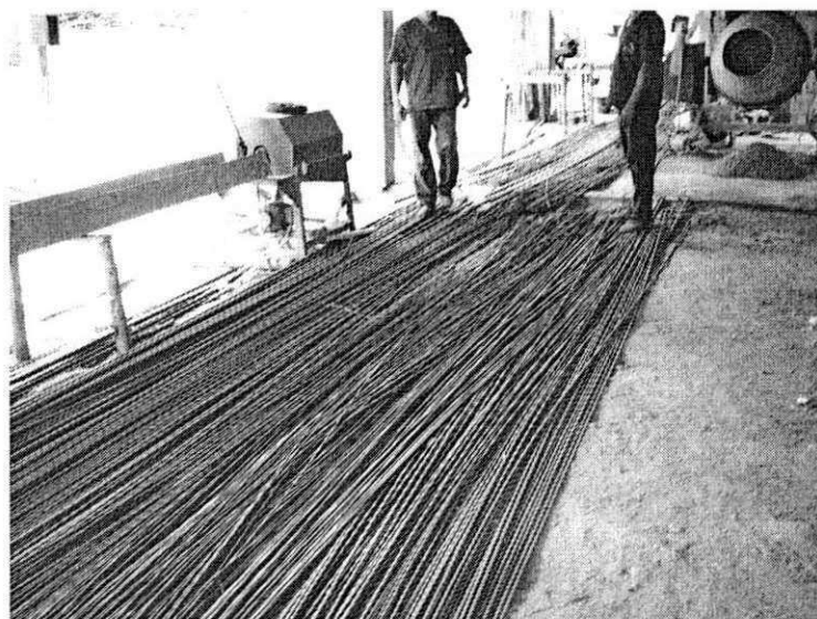
Figura 05 – Armazenamento do Ferro
