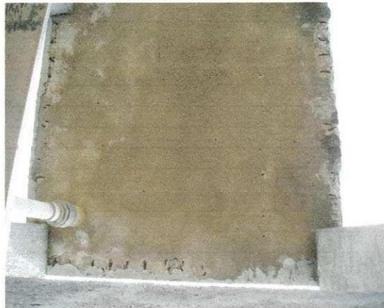
Foto 6 – Corrosão nas armaduras(caixa d'agua)
