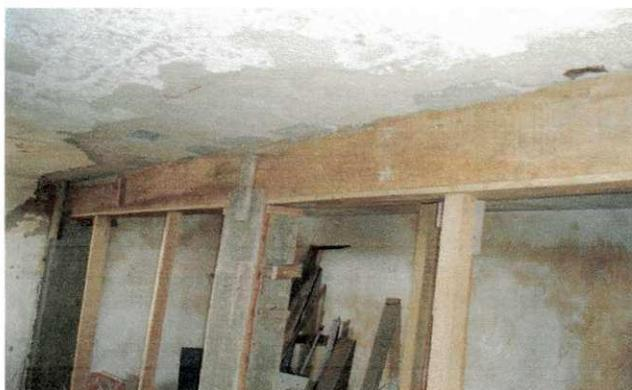
Foto 3-Forma para viga e pilar
