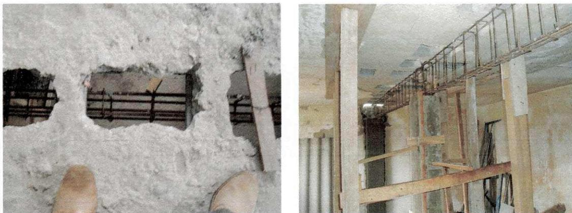
Foto 5-Reforço em laje pré-moldada
