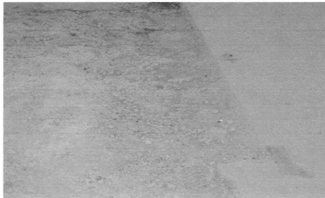
Foto 4-Nivelamento do piso sobre concreto magro
