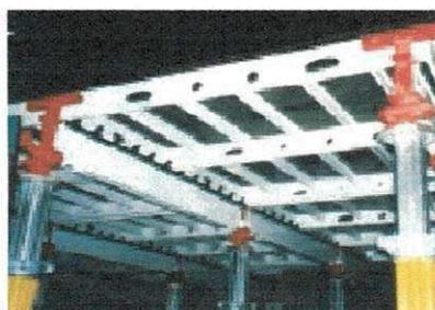
**Figuras 17 e 18** -Laje nervurada formada por lajes pré-fabricadas com incorporação de blocos de isopor (cortesia lajes Anhanguera) e estrutura de cimbramento de alumínio (cortesia Peri).
