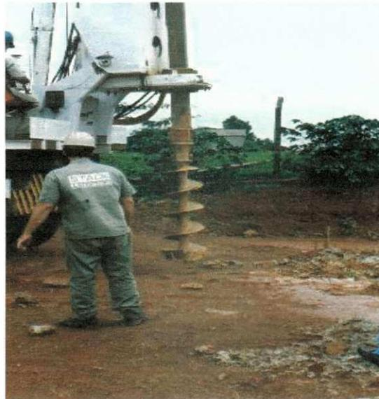
Figura 7 - Detalhe do elemento de escavação.
