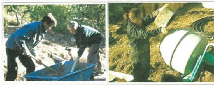
Figura 10: Concreto virado na obra
