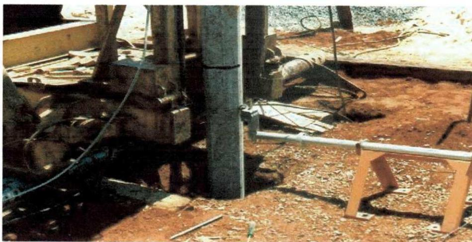
Figura 9 - Cravação de estaca pré-moldada.
