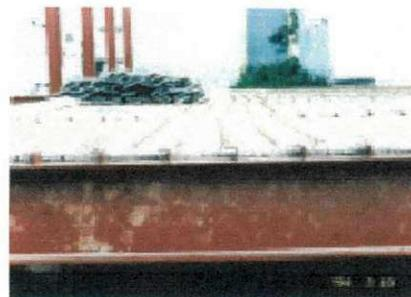
Figuras 13 e 14 - Operação de alinhamento das vigotas e painéis treliçados (cortesia Lajes Anhanguera)
