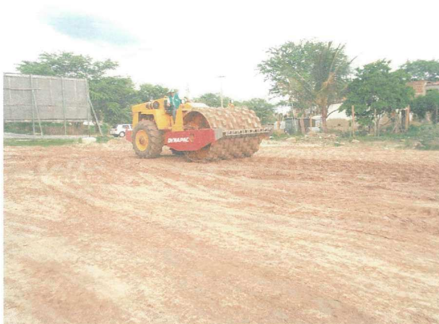
FIGURA 3 – Execução de aterro
