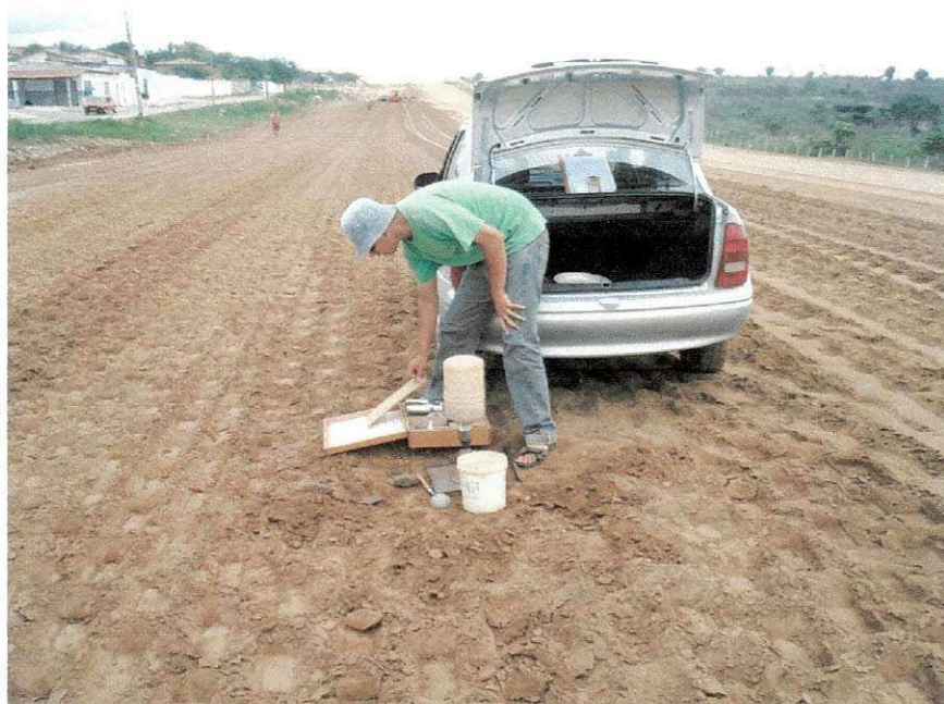
FIGURA 4 – Realização do controle tecnológico
