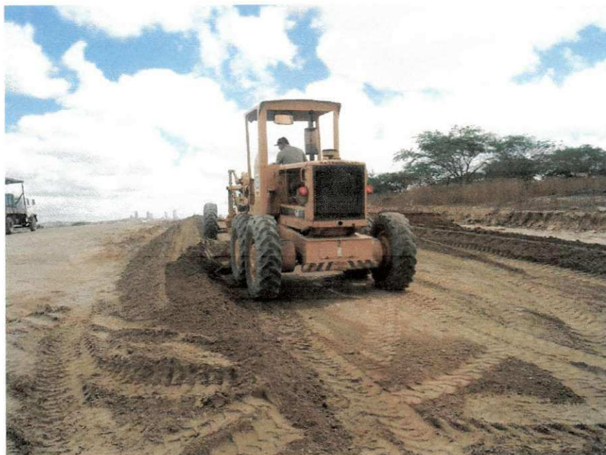
FIGURA 7 – Execução de base
