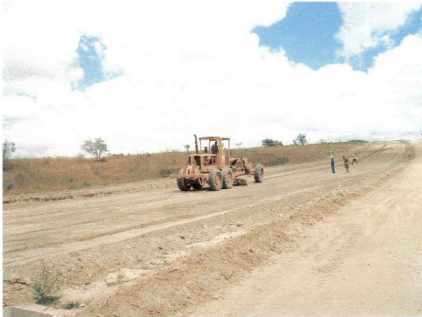
FIGURA 5 – Execução de sub-base
