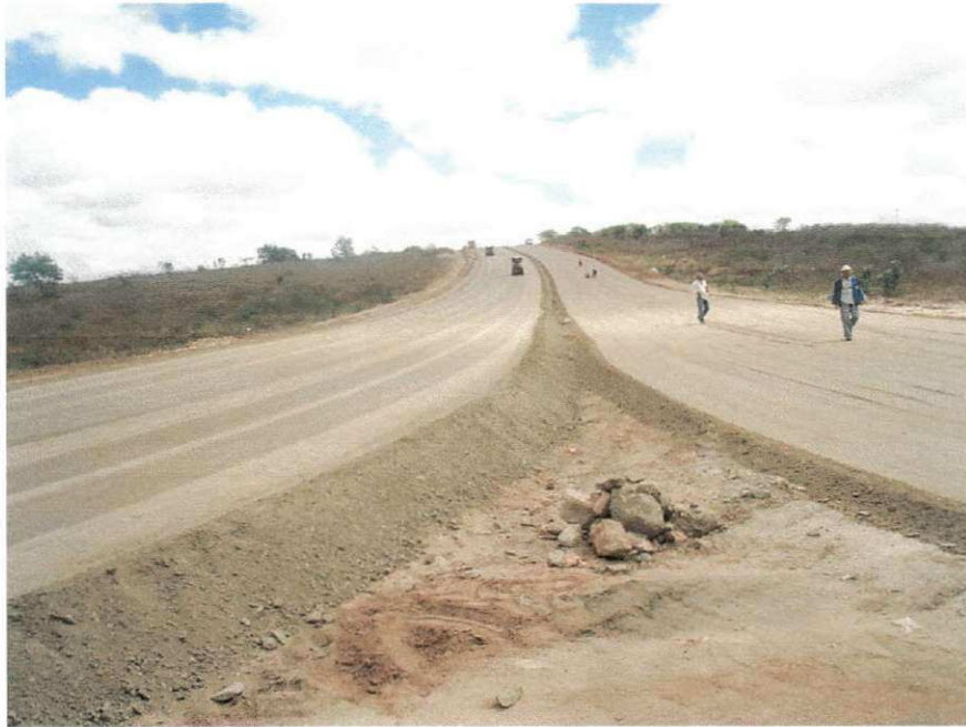
FIGURA 6 – Execução de sub-base
