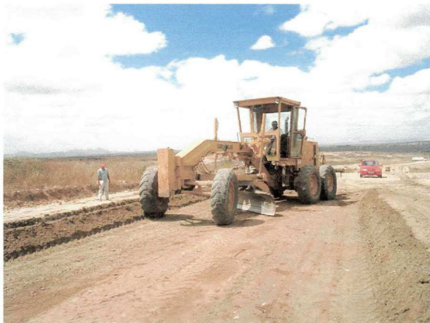
FIGURA 8 – Execução de base
