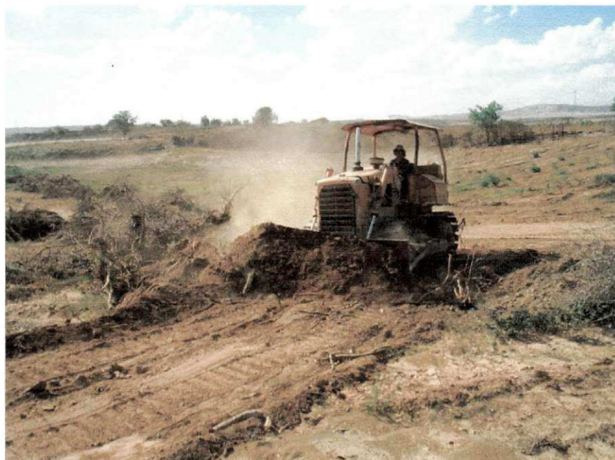
FIGURA 2 – Execução de corte
