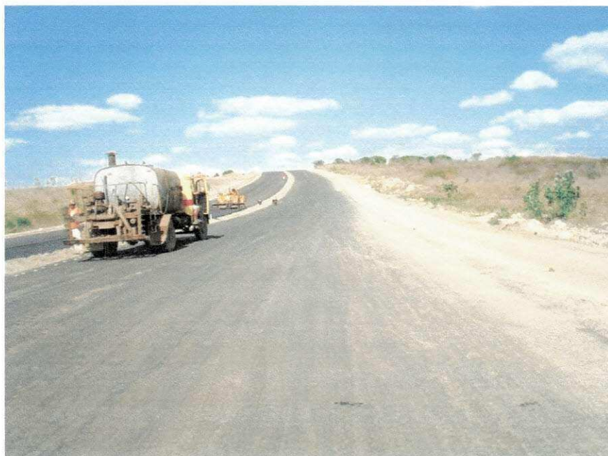
FIGURA 9 – Imprimação executada
