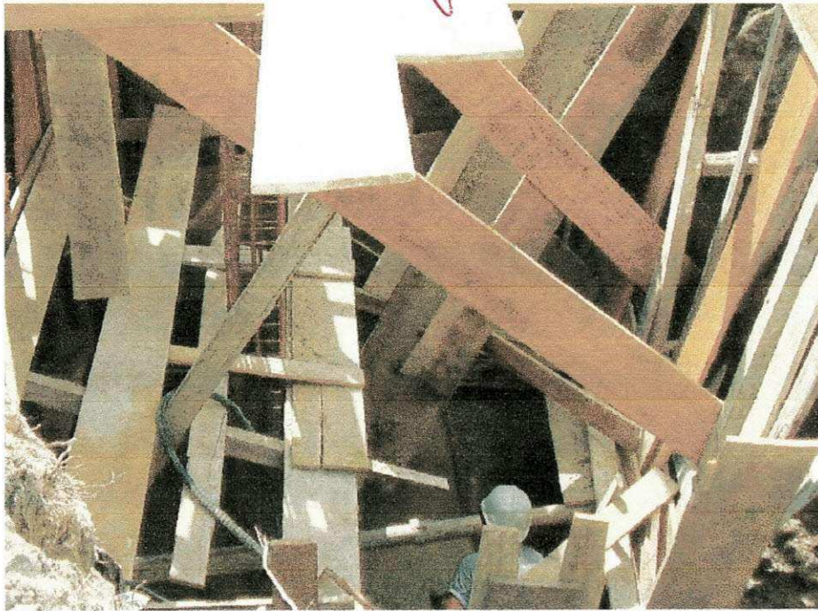
Figura 4.38 – Concretagem da sapata S16.
