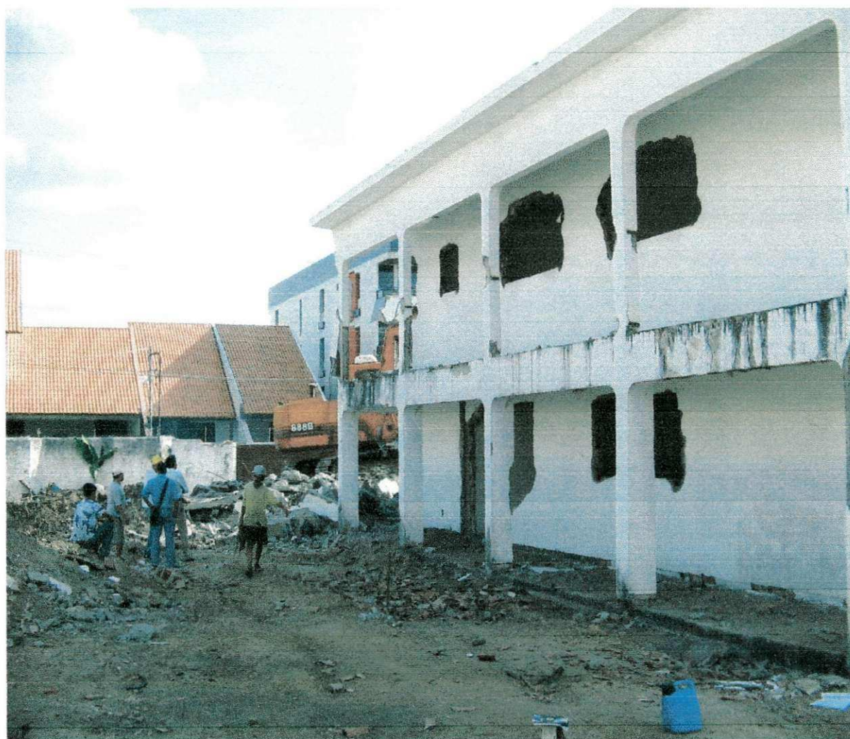
Figura 3.3 – Foto da estrutura que foi demolida.
