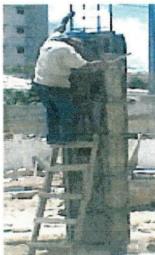
Figura 2.8.- Retirada da fôrma de um pilar.
