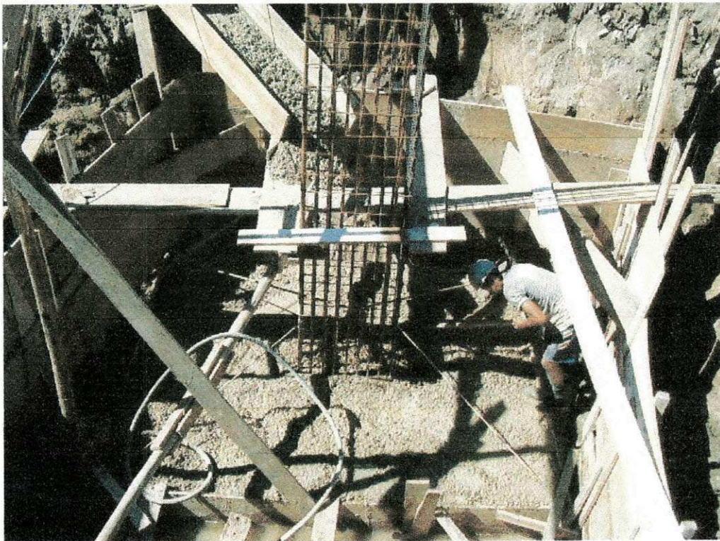
Figura 4.41 – Concretagem da sapata S10.
