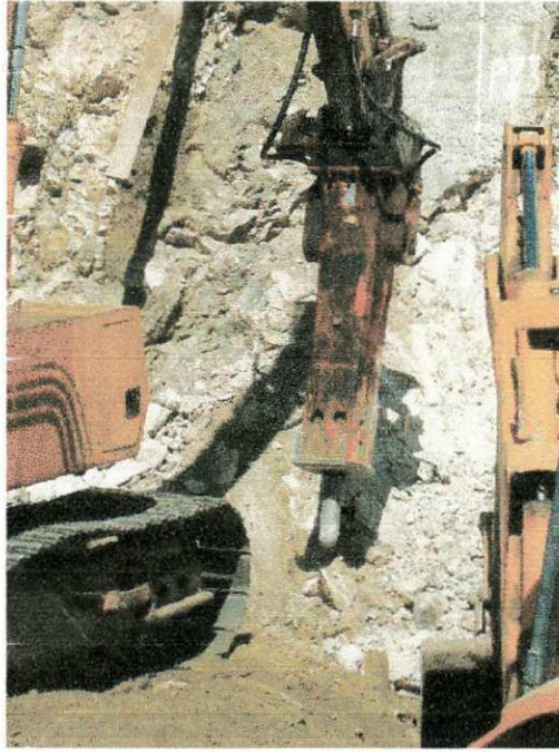
Figura 4.3 – Retro escavadeira com rompedor hidráulico.
