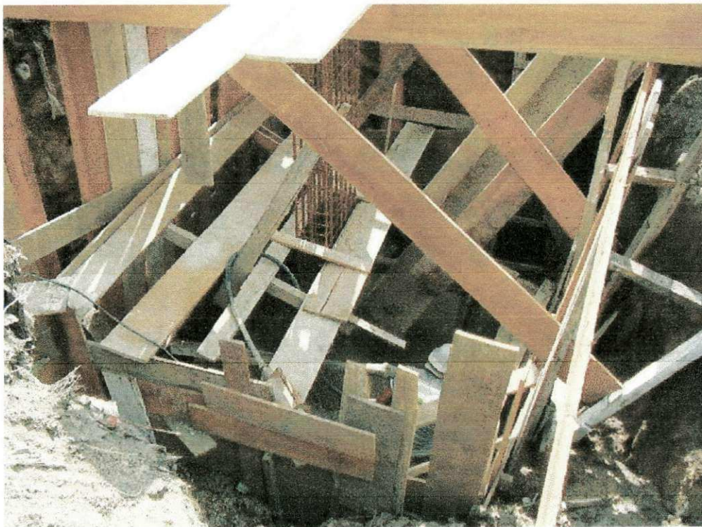
Figura 4.37 – Foto da sapata S16.
