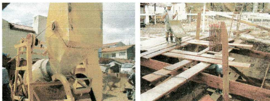
Figura 4.7 e 4.8 – Produção e transporte do concreto dentro da obra.
