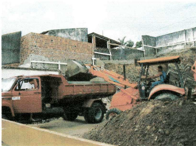
Figura 4.4 – Retro escavadeira colocando o entulho na caçamba.
