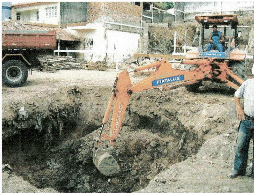
Figura 4.5 – Retro escavadeira cavando uma vala.
