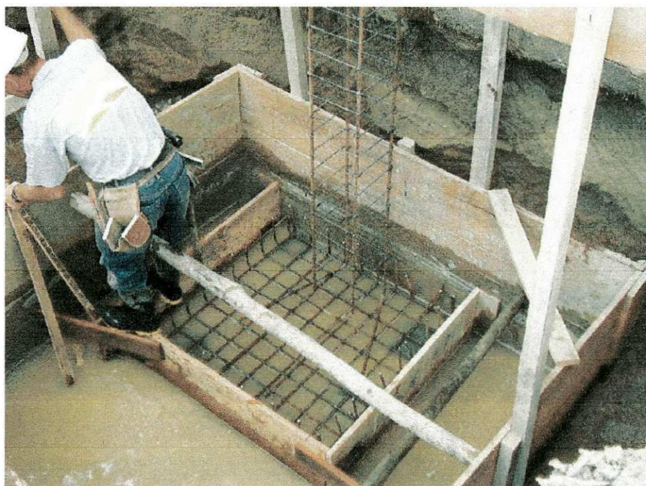
Figura 4.15 – Concretagem da sapata S 57.
