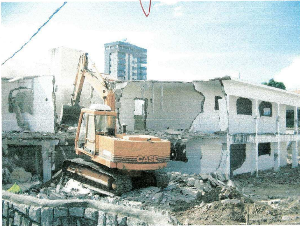
Figura 3.4 – Foto da máquina realizando a demolição.
