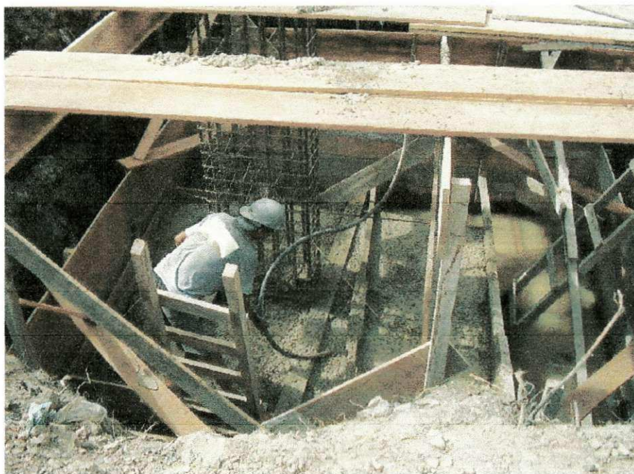
Figura 4.19 – Foto da concretagem da sapata S23.
