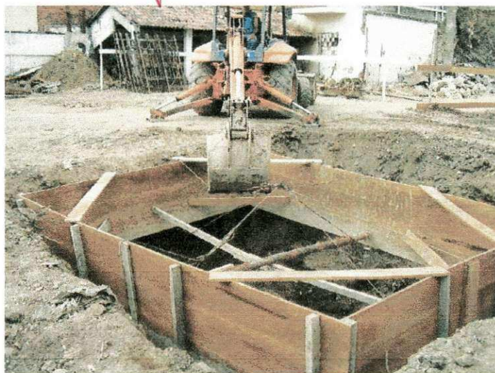
Figura 4.6 – Retro escavadeira colocando o caixão na vala da sapata.
