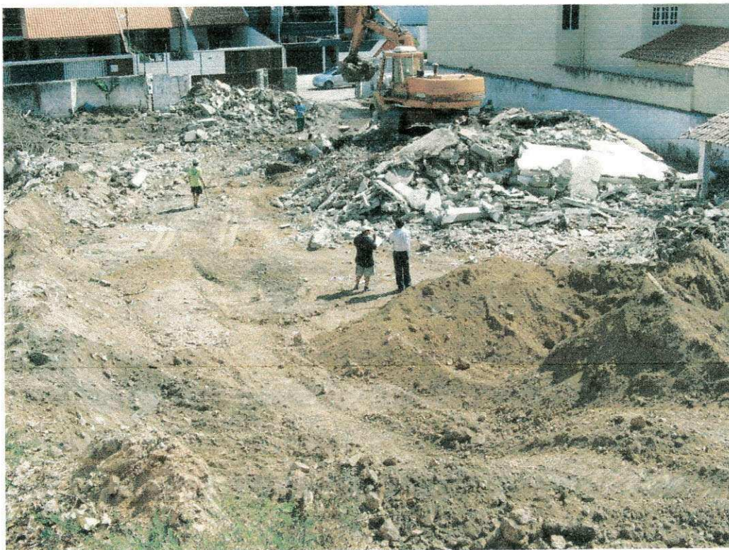
Figura 3.5 – Foto do terreno depois de concluída a demolição.
