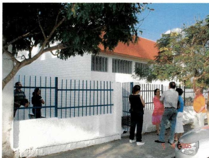
Fig. 4 – Fachada principal da UBSF Inácio Mayer Fonte: Pesquisa direta (2005)
