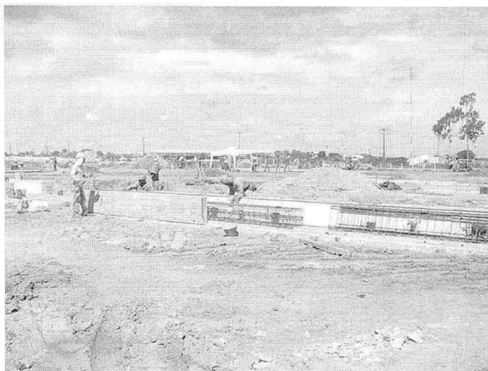
Foto – 3: Concretagem de pilares pré-moldados (na própria obra)
