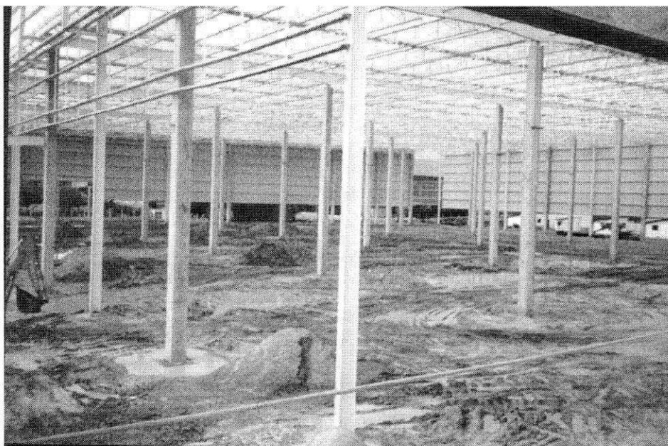
Foto – 4: Pilares pré-moldados e metálicos já erguidos. Cobertura e fechamento lateral em estrutura metálica. Solo bastante castigado pelas chuvas.
