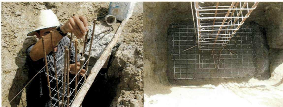
Figura 3 – Colocação das ferragens em prumo e esquadro
