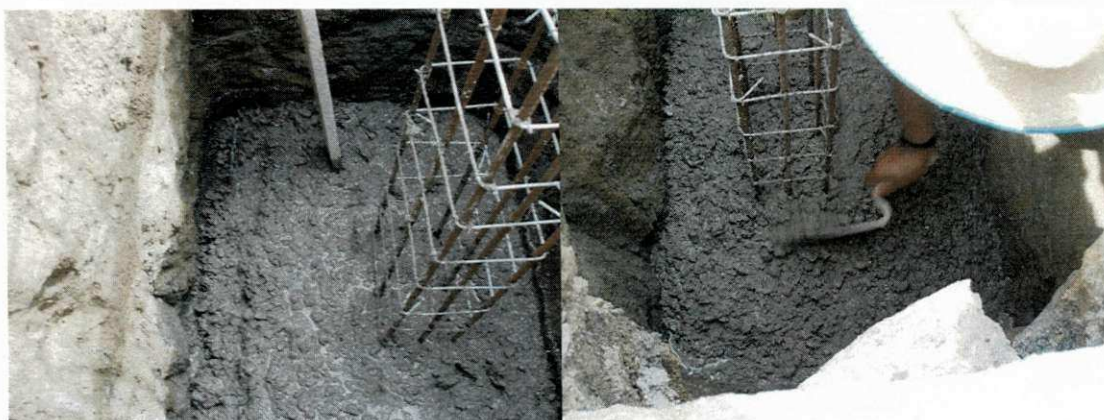
Figura 4 – Concretagem da sapata e acabamento final
