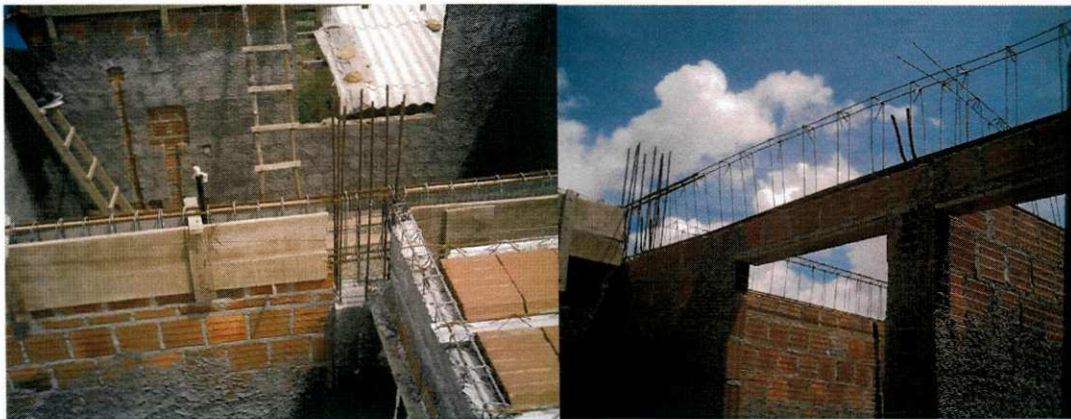
Figura 7 – Concretagem das vigas
