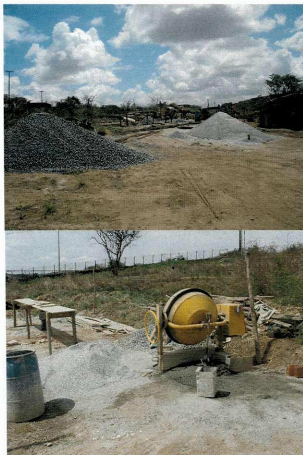
Figura 1 – Canteiro de obras
