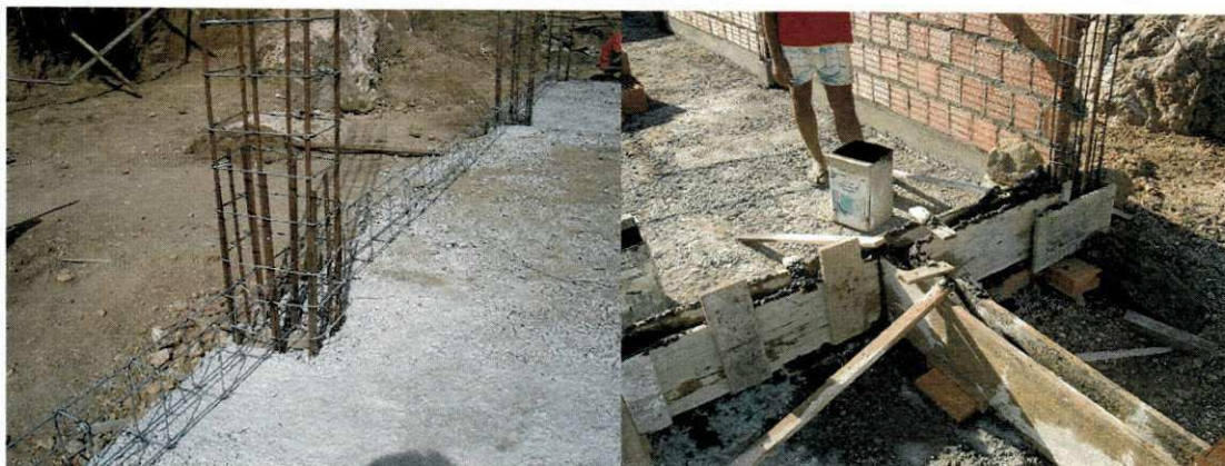
Figura 8 – Cintas executadas no nível mais alto
