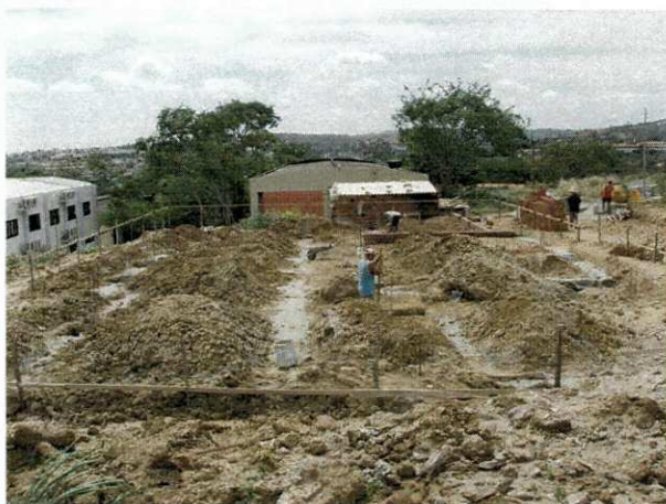
Figura 2 – Locação e limpeza da obra executados
