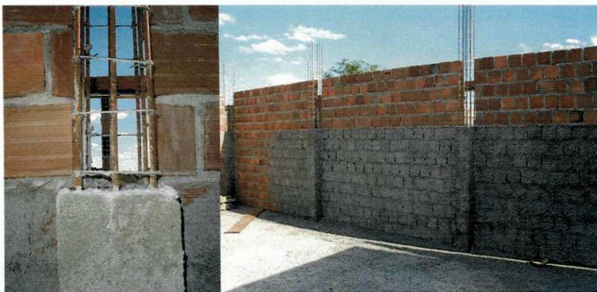
Figura 6 – Pilares executados a 1,50m
