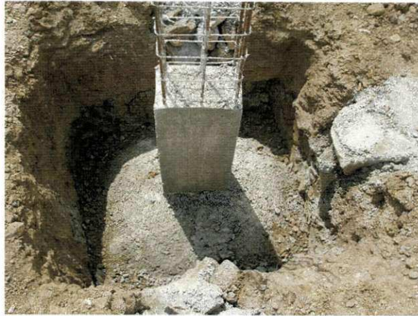
Figura 5 – Sapata e fuste prontos
