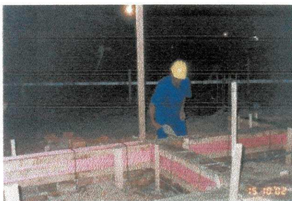
Figura 14 – Utilização de traveamento.
