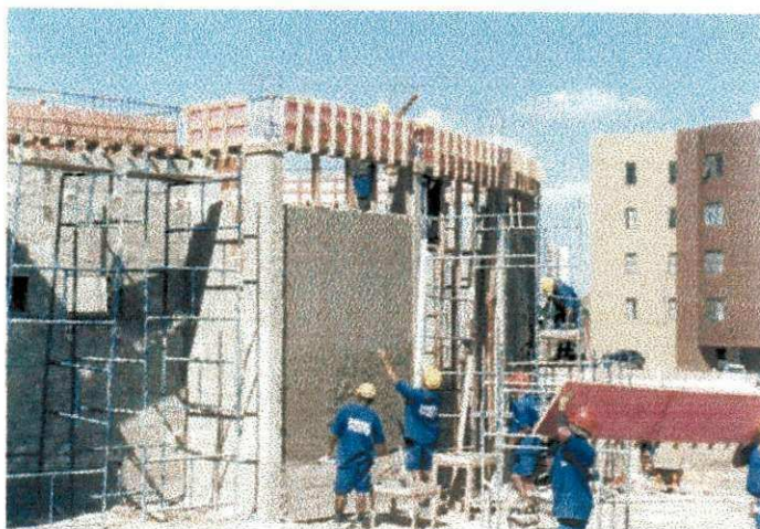
Figura 26 – Escoramento das vigas e face lateral externa das fôrmas.
