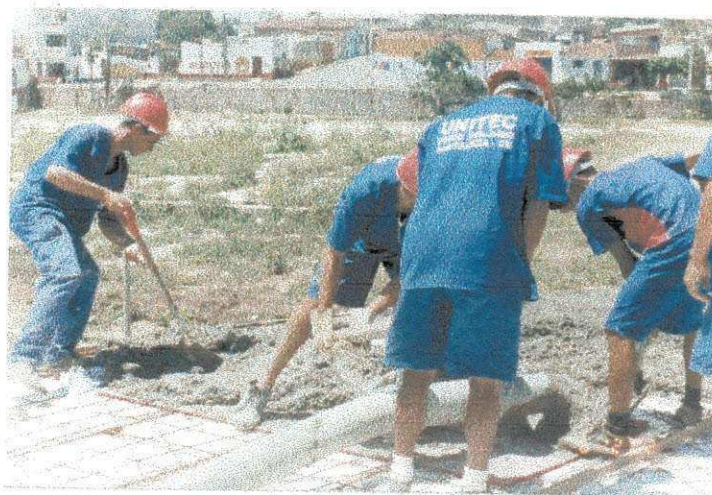
Figura 33 – Lançamento do Concreto Usinado
