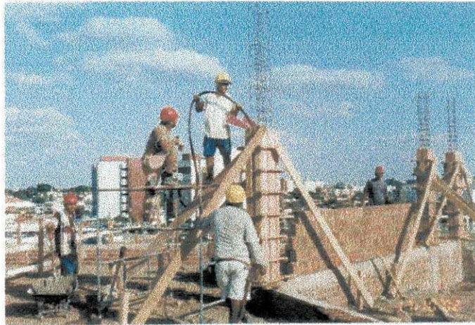
Figura 24 – Adensamento do concreto com vibrador de imersão.
