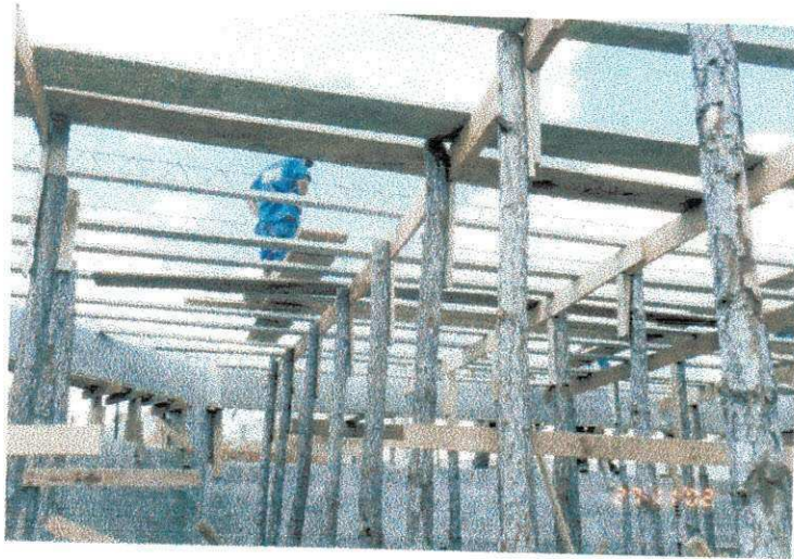
Figura 32 – Escoramento das lajes.
