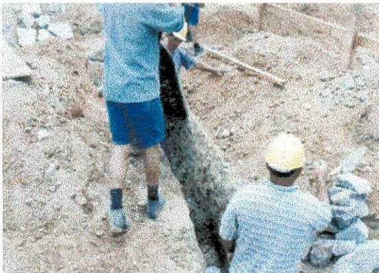
Figura 1 – Colocação do concreto ciclópico
