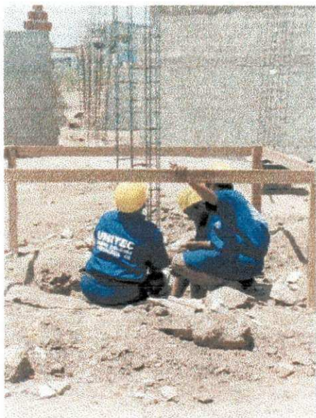
Figura 20 – Colocação da armadura.
