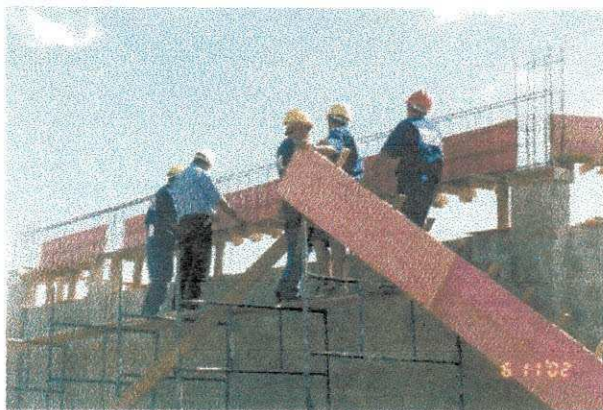
Figura 12 – Colocação das fôrmas das vigas.
