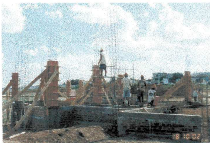
Figura 23 – Pilares em fase de concretagem.
