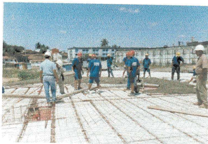
Figura 34 – Concretagem das lajes
