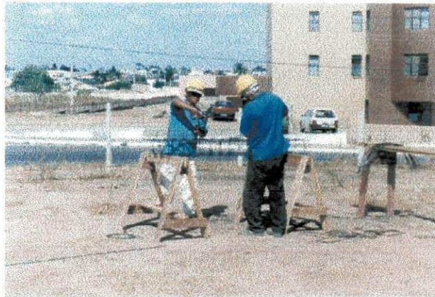
Figura 15 – Confecção das armaduras.
