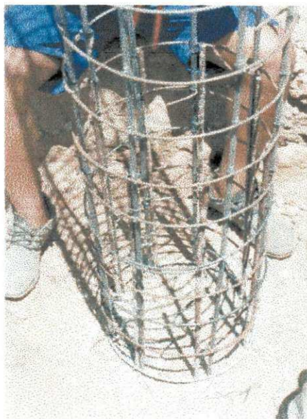
Figura 21 – Verificação do prumo.
