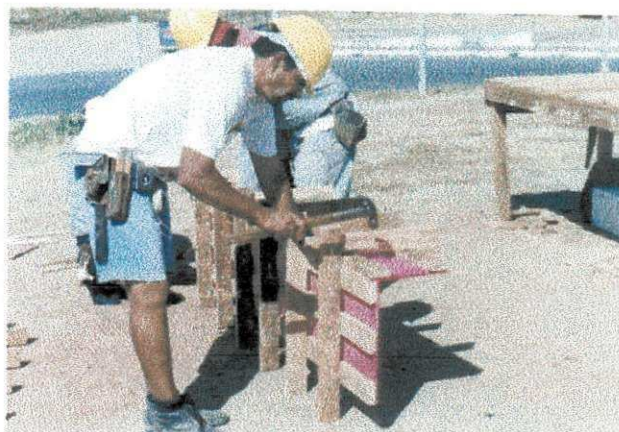
Figura 10 – Montagem das fôrmas.
