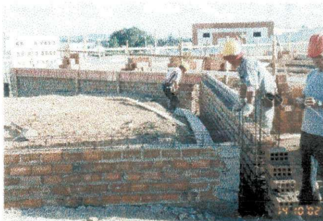
Figura 28 – Colocação das cintas.
