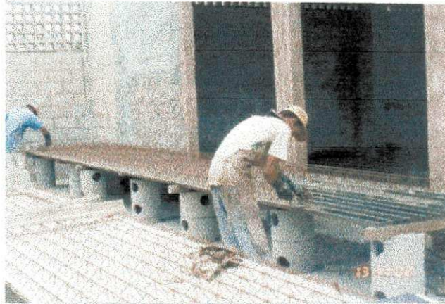
Figura 7 – Concretagem das treliças.
