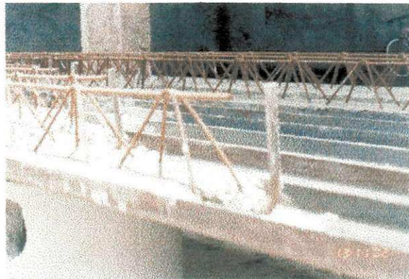
Figura 8 – Armadura de reforço positiva das treliças.
