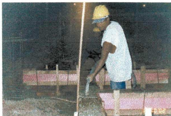
Figura 29 – Concretagem das cintas.
