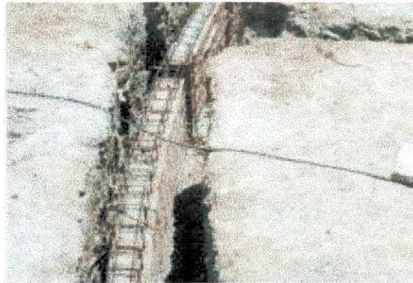
Figura 4 – Cinta sobre alvenaria de embasamento.
