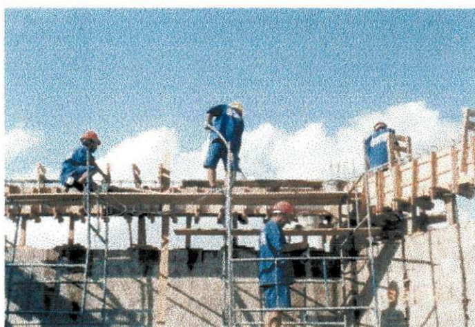
Figura 27 – Concretagem das vigas com espera para a laje.
