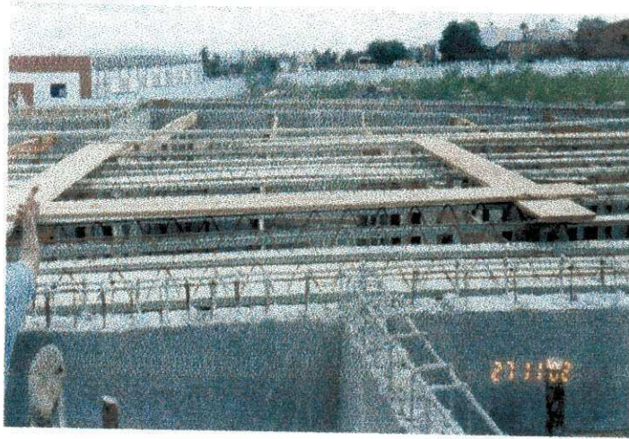
Figura 29 – Tábuas para os trabalhadores caminharem.
