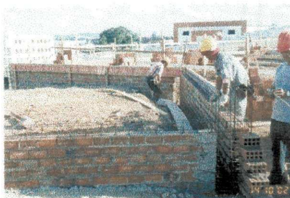
Figura 11 – Colocação das fôrmas das cintas.
