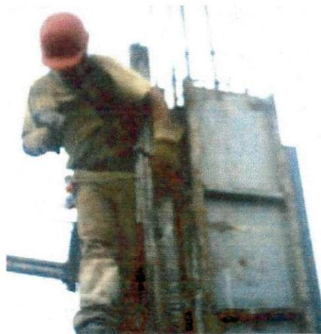
Foto 10 - Trabalhador usando equipamentos de proteção: cinto, luvas e capacete.
