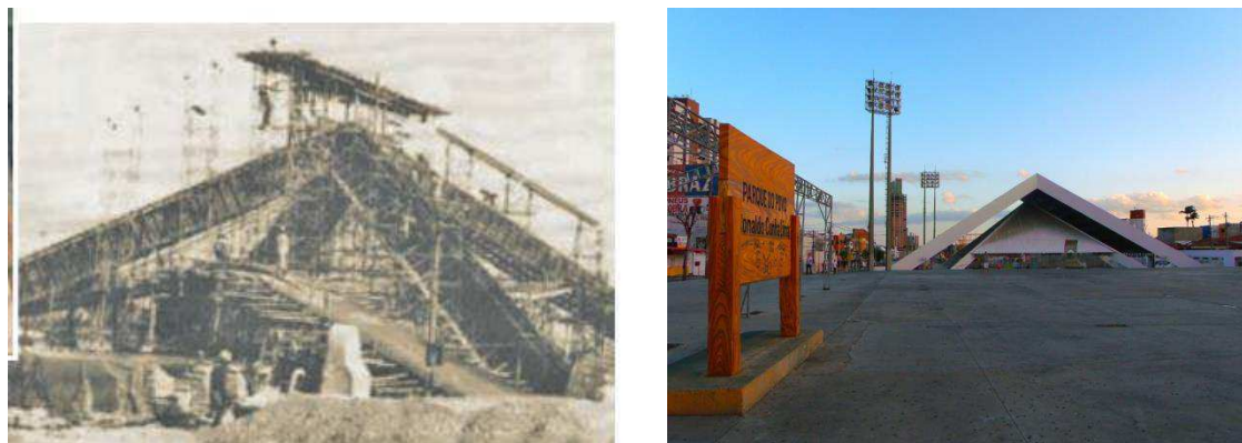
FOTO 6 e 7: Parque do povo em construção (á esquerda) e hoje (à direita). FONTE: BlogCGRetalhos, 2016, e Google Imagens, 2017.
