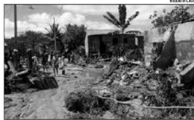
PONTO CRÍTICO/ Casas foram destruídas no bairro Novo Bodocongô
