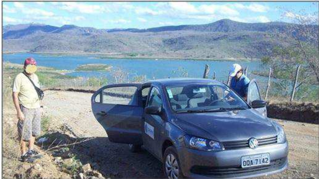
Figura 12: Visita da CAGEPA à Barragem Acauã, Dez. 2013 Fonte: MAB. Acesso em 13 de Maio de 2016.
