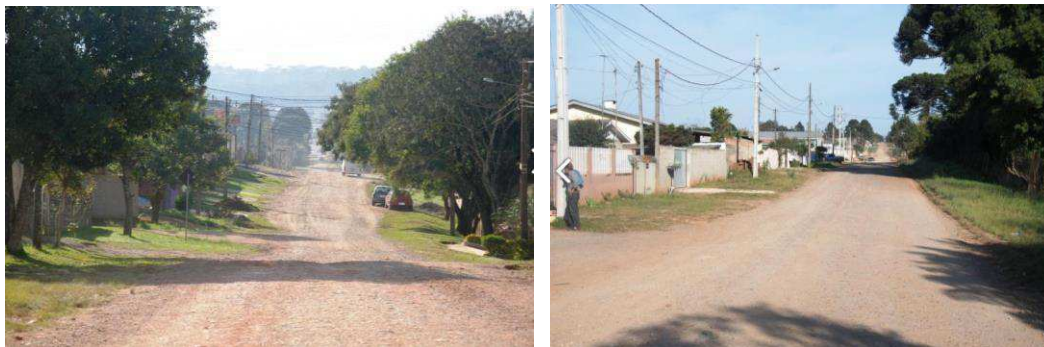
Figuras 17 e 18: Avenida Juscelino Kubitschek antes da pavimentação Fonte: Prefeitura Municipal de Campina Grande, 2000. Acesso em: 14 jul. 2016.
