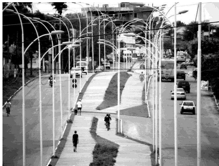
Figura 19: Avenida Juscelino Kubitschek após a pavimentação Fonte: http://apalavraonline.com.br , 2011. Acesso em: 14/07/2016
