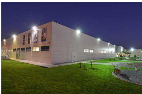
Figura 15: AeC após a expansão Fonte: http://www.aec.com.br/Site , 2014.
