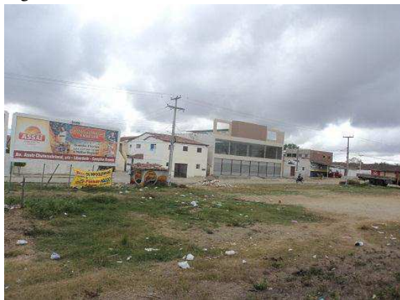
Figura 15: Galeria comercial em fase de conclusão.
