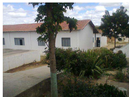
FIGURA 2: Vista externa das salas de aula da escola
