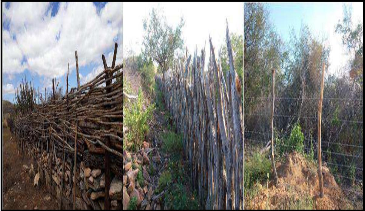
**Figura 06** – Cerca de pedras com cama de estacas, cerca de estacas e cerca de estaca com arame farpado. Fonte: Acervo próprio.
