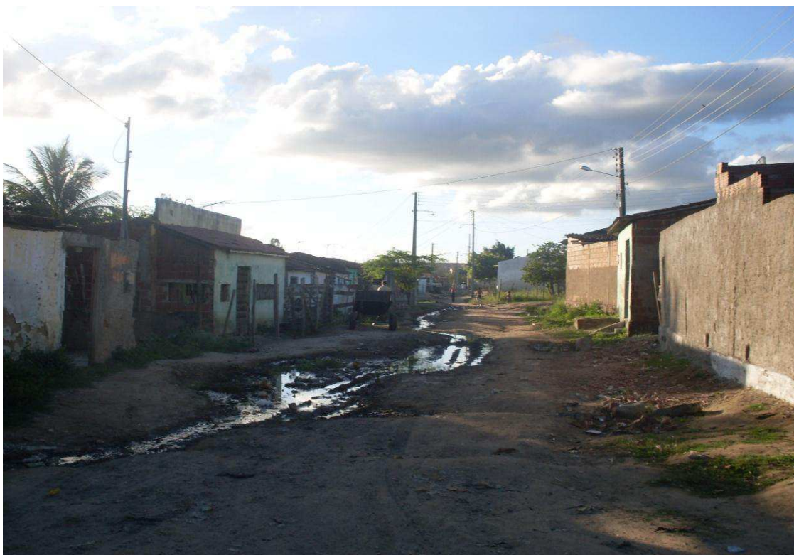
Figura 5:: Rua Ubajara – Bairro das Cidades. Observa-se na imagem a ausência de calçamento e o esgoto correndo a céu aberto. Foto: Ana Carolina Nogueira Santos/ Agosto de 2013.
