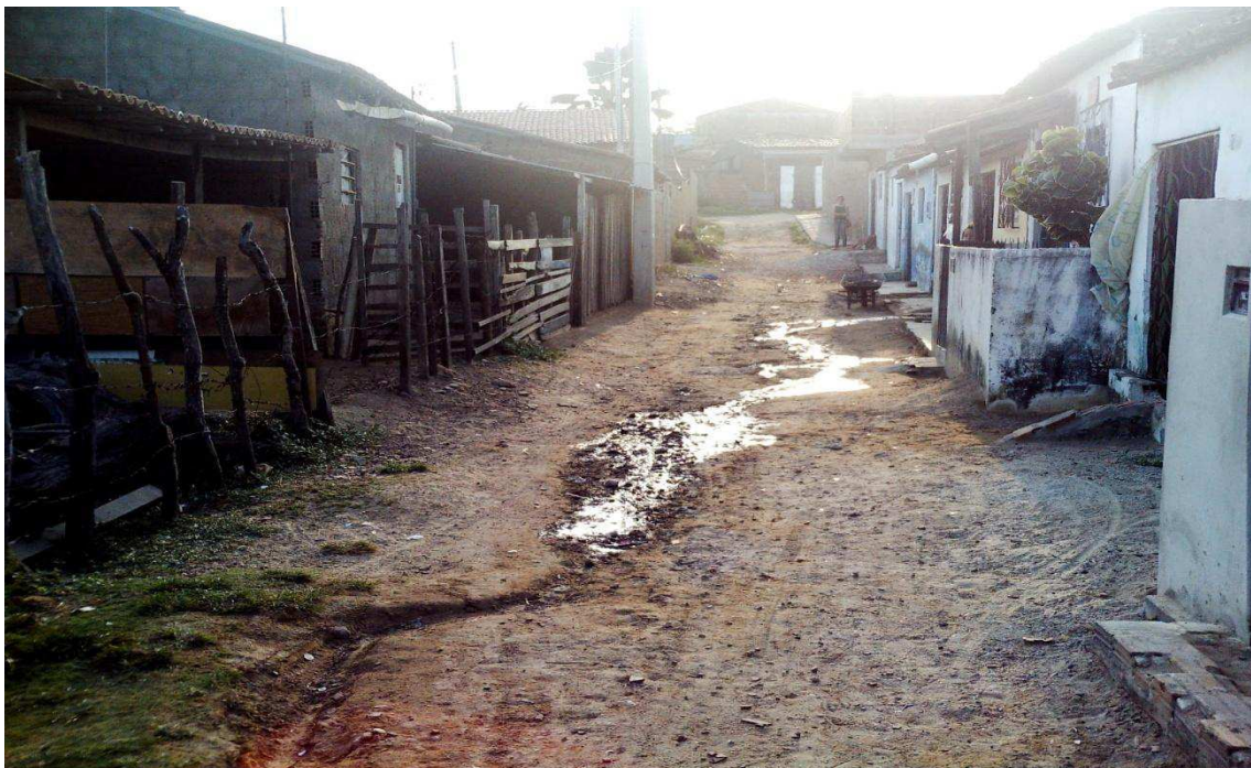
Figura 9: Travessa Fortaleza – ZEIS Invasão de Santa Cruz. Observa-se na imagem a ausência de calçamento e o esgoto correndo a céu aberto. Foto: Ana Carolina Nogueira Santos / 2013.
