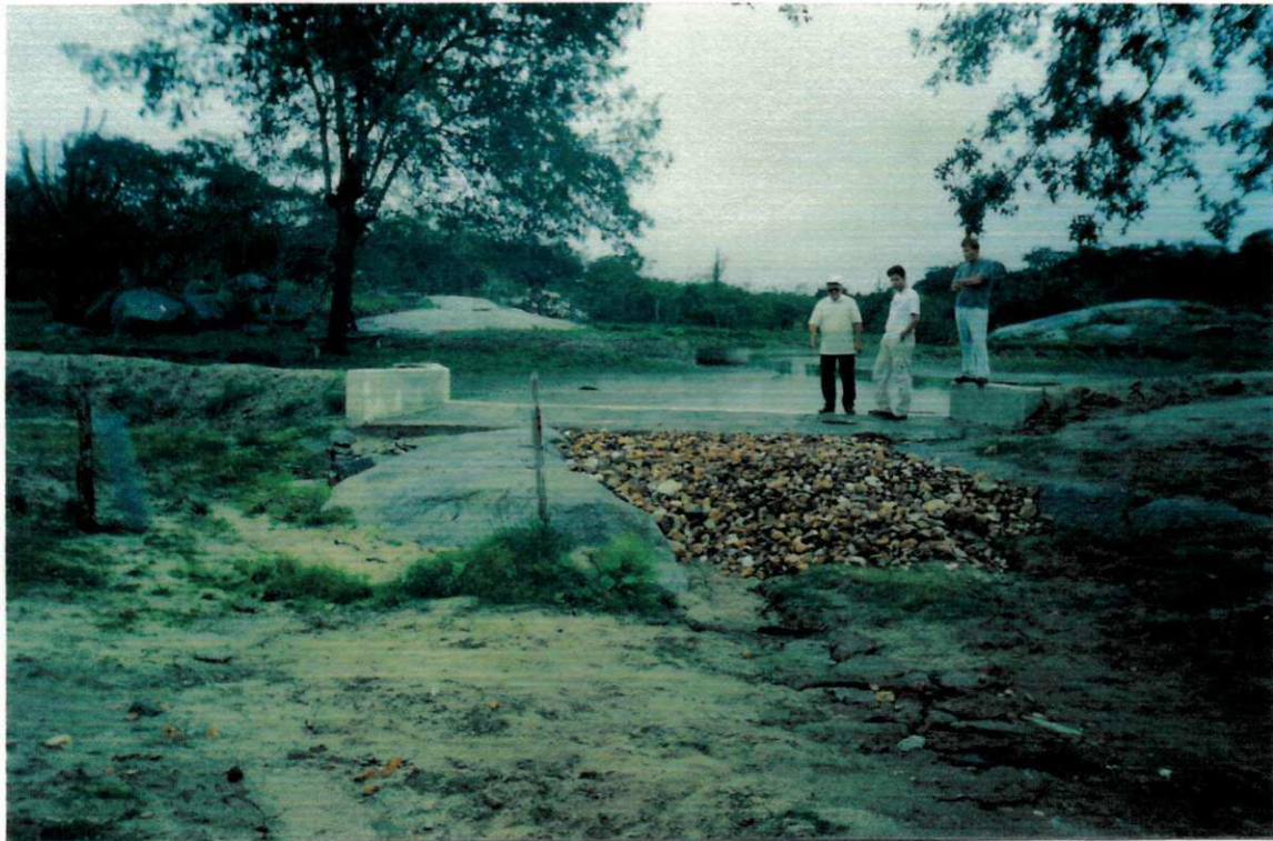
Fotografia 10. Mostra o grande cuidado que os agricultores experimentadores têm com as barragens com o objetivo de evitar a erosão.
