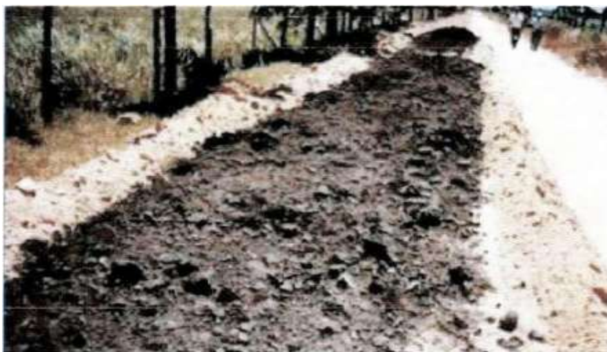
Figura 6 - Execução da técnica de Roadspreading
