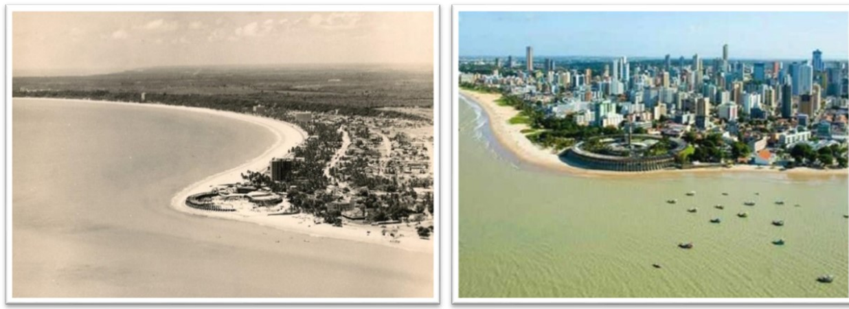
Figura 17 e Figura 18: Construção do Hotel Tambaú, vista aérea (em 1970 e 2012)
