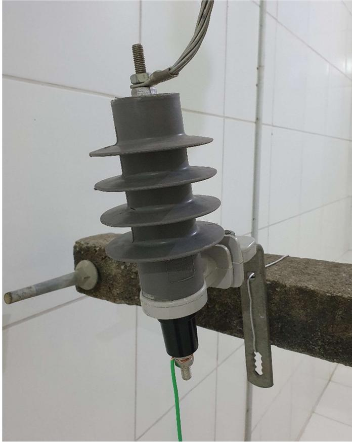
Figura 20 – Para-raios modelo 39E da fabricante BALESTRA.
