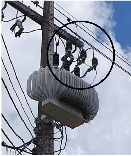
Figura 4 – Instalação de um para-raios de distribuição junto de transformador [3].
