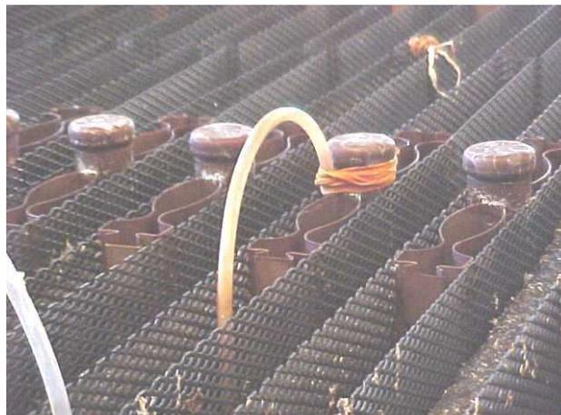
H – Detalhe da integridade da fita teflon utilizada para a fixação dos tubos.
