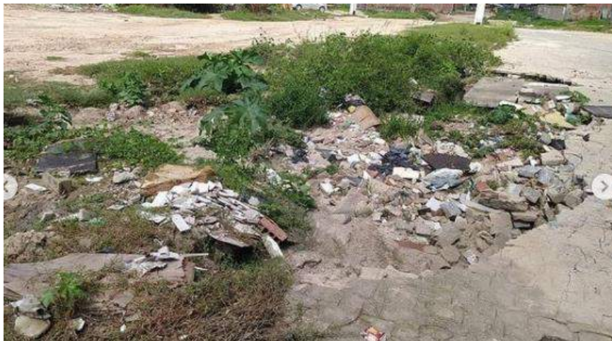
Figura 25: Danos no pavimento das ruas após as chuvas
