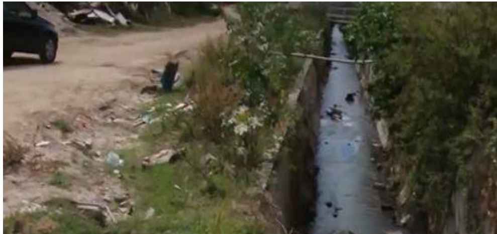
Figura 26: Condições do entorno do Canal da Ramadinha - 29/09/2020
