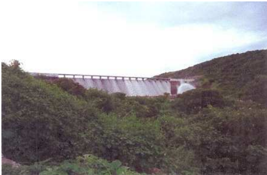
Foto 05 – Primeira sangria da barragem Acauã, vendo-se ao longe o seu vertedouro.
