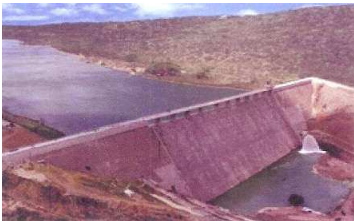
Foto 04 – Vista aérea da barragem de Acauã, no início do enchimento do lago, o que obrigou a população local a sair às pressas para se abrigar em áreas mais altas.
