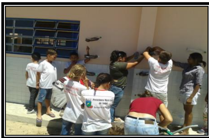
Fotografia 3 - Construção de Horta suspensa com garrafas PET
