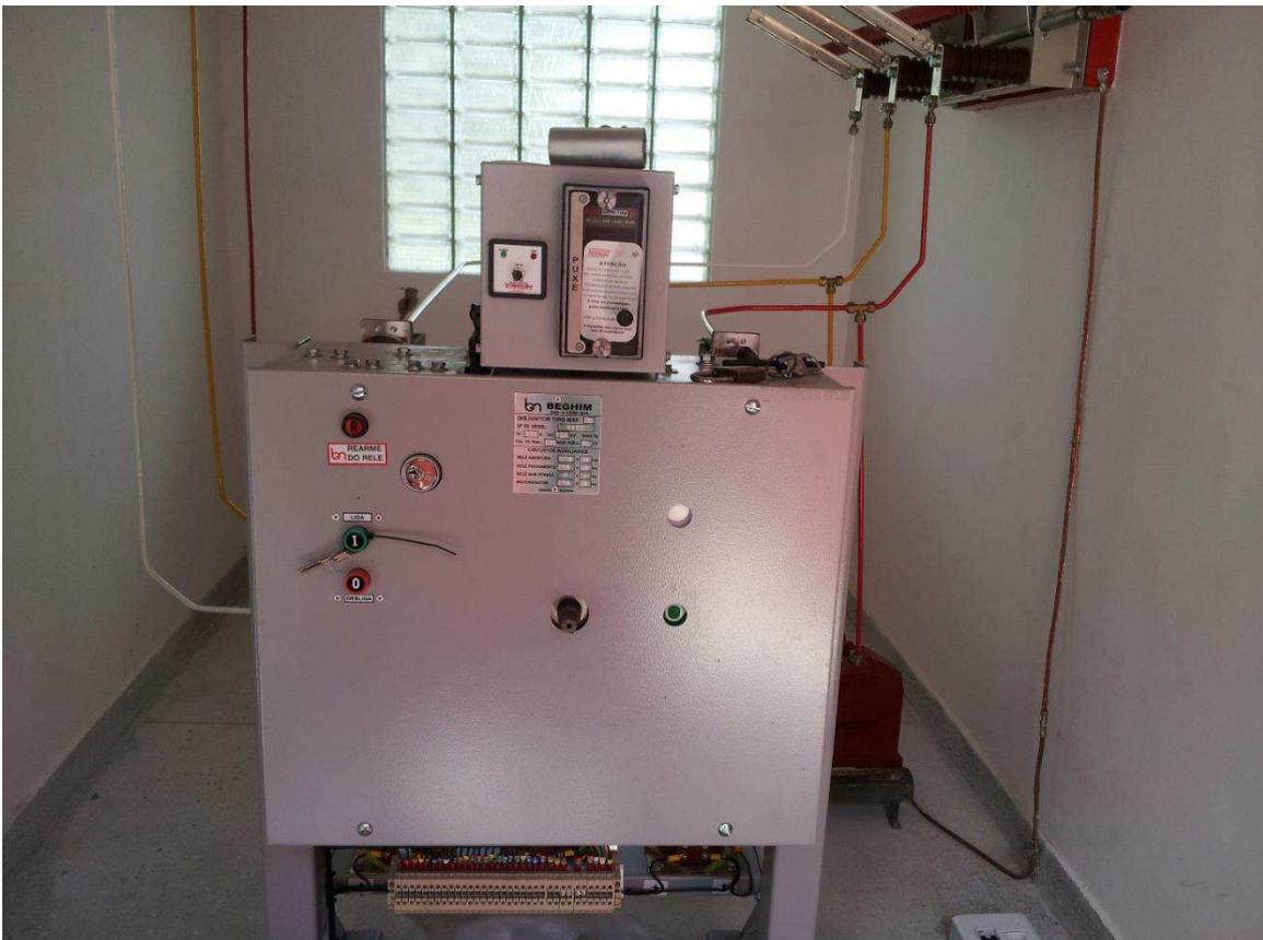
Figura 22: Relé de sobrecorrente usado para proteção
