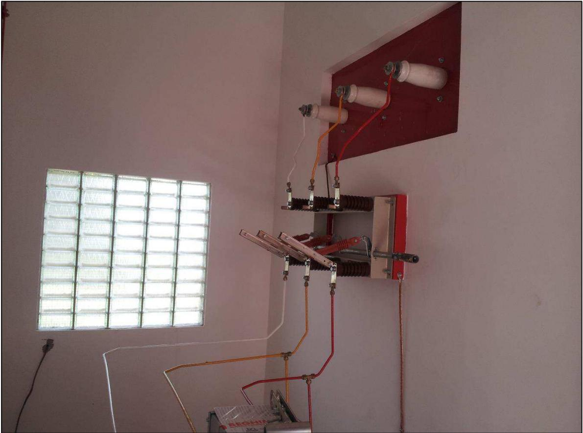
Figura 23: Destaque à saída do relé para a medição, com chaves seccionadoras
