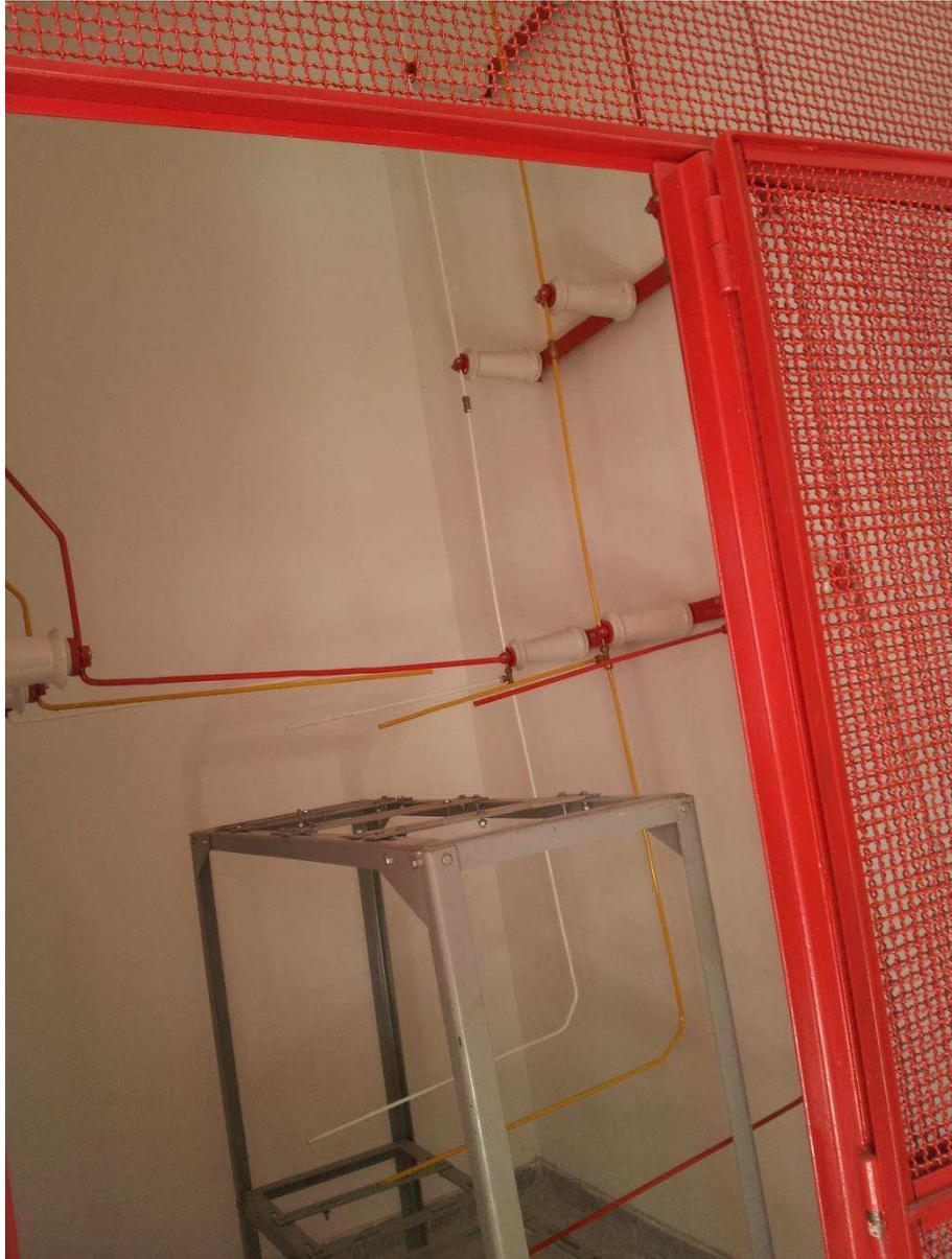
Figura 25: Parte fechada com o TP e TC para medição
