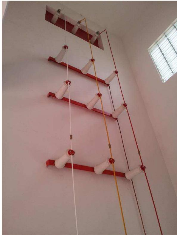
Figura 21: Barramentos de descida para o relé
