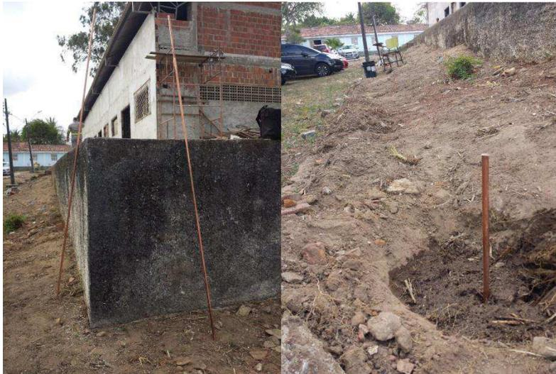
**Figura 3. Hastes de aterramento antes e depois da penetração no solo.**
