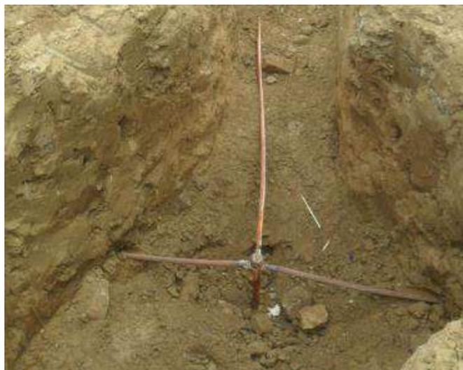
Figura 110. Fotografia da haste de aterramento implantada e soldada a malha de terra.
