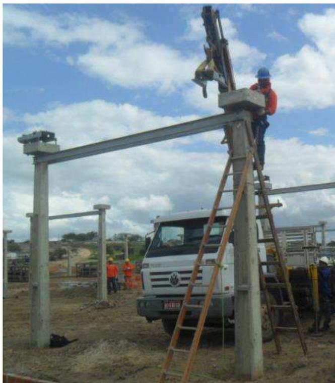
Figura 66. Fotografia da montagem dos chassis no capitel da CS SPO.
