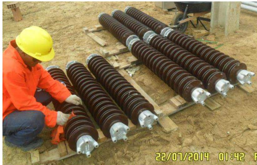
Figura 73. Fotografia da limpeza dos isoladores da CS SPO.
