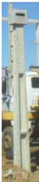
Figura 53. Fotografia do poste com capitel utilizados para o suporte do para-raios de 500 kV.
