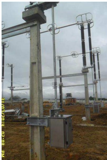
Figura 82. Fotografia da conexão do armário de controle com a coluna rotativa.
