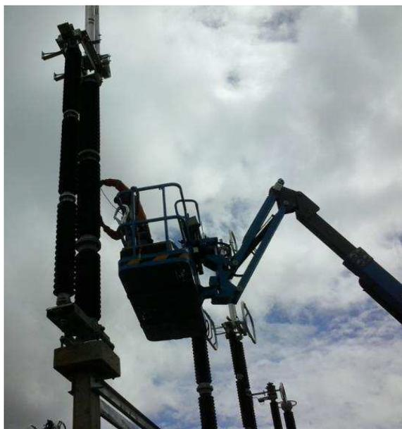
Figura 83. Fotografia da regulagem dos isoladores da CS SPO.
