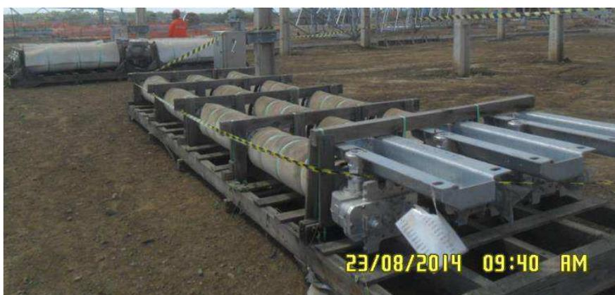
Figura 40. Fotografia da distribuição dos disjuntores de 500 kV para a montagem.
