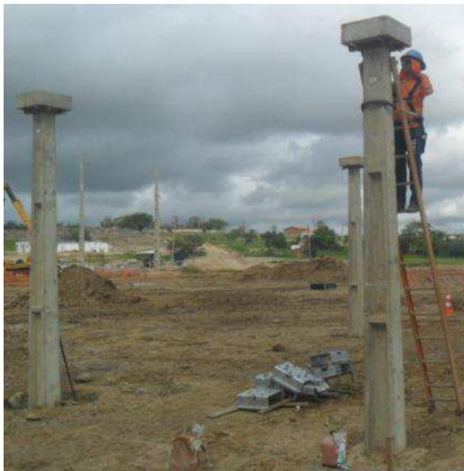
Figura 61. Fotografia do poste com capitel utilizado para suporte CS SPO.
