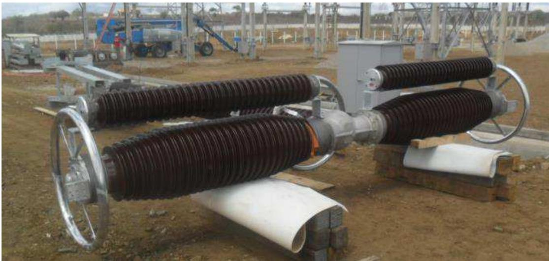
Figura 47. Fotografia da fase de um disjuntor de 500 kV preparada para ser montada na base de concreto.
