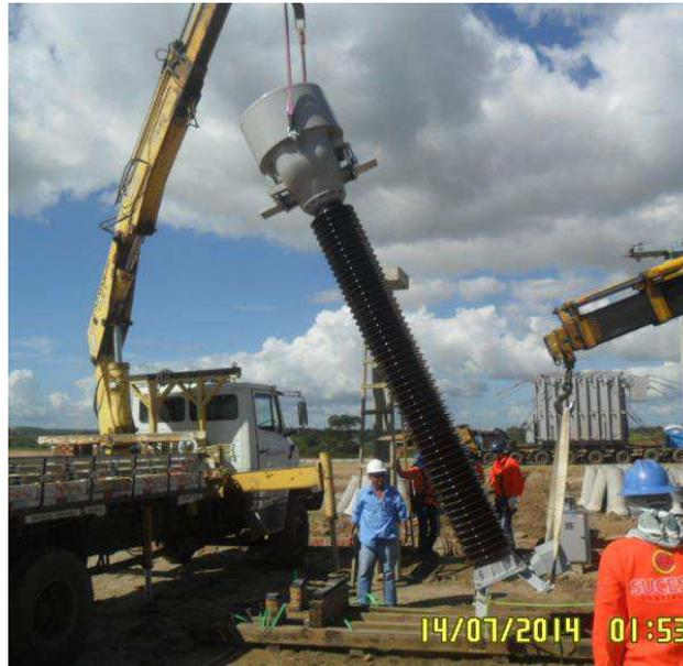
Figura 15. Fotografia do momento antecedente a suspensão completa no ar do TC de 500 kV.
