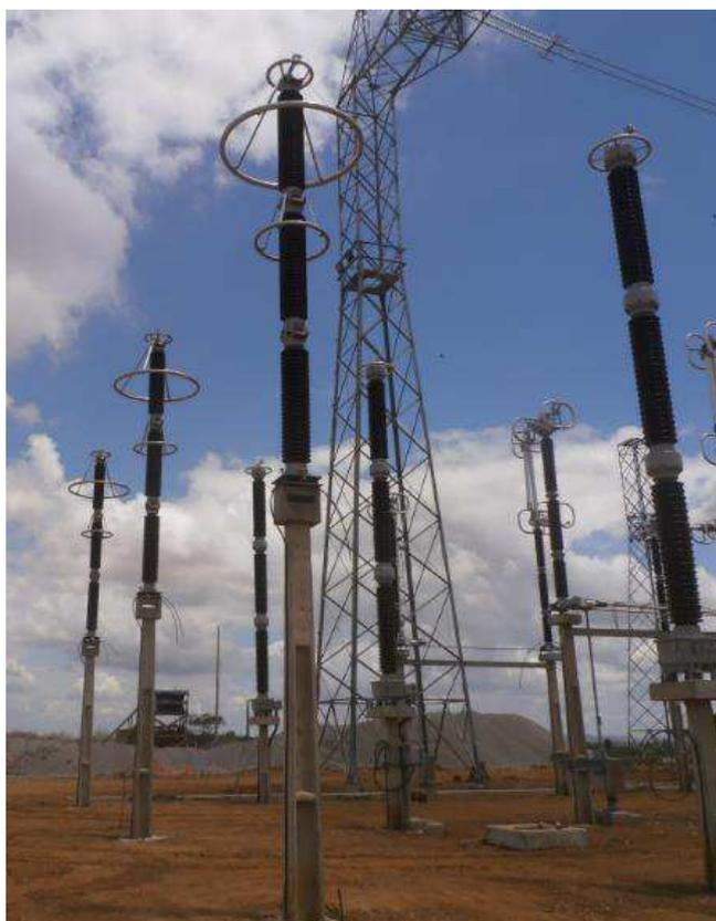
Figura 58. Fotografia dos para-raios de 500 kV montados presente na alimentação da subestação.
