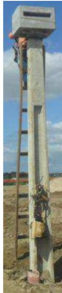
Figura 30. Fotografia de um poste com capitel utilizado para o suporte do isolador pedestal de 500 kV.
