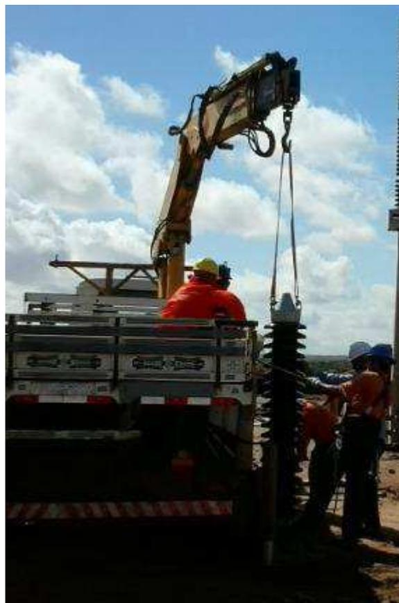
Figura 35. Fotografia da base de um IP de 500 kV apoiada ao caminhão *munk*.
