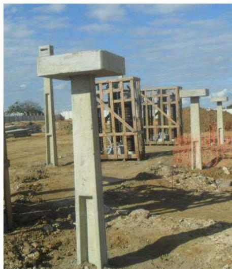
Figura 20. Fotografia de um poste utilizado para o suporte do TPC de 500 kV.
