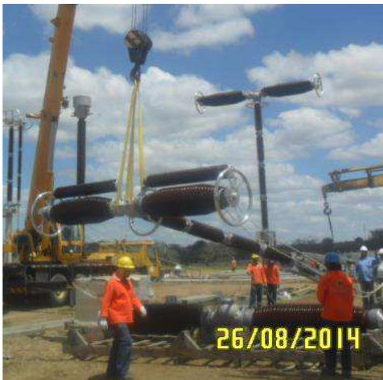
Figura 48. Fotografia de um guindaste levantando a fase de um disjuntor de 500 kV com auxílio de um caminhão *munck*.
