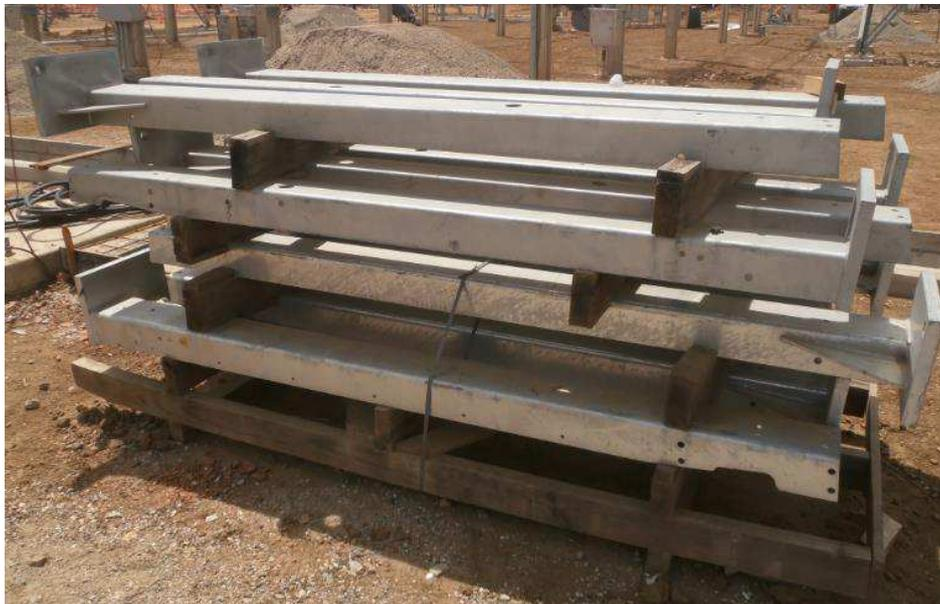
Figura 42. Fotografia das bases metálicas de um disjuntor de 500 kV.
