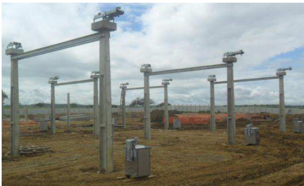
Figura 68. Fotografia dos postes de suporte para a CS SPO com os *chassis* instalados.
