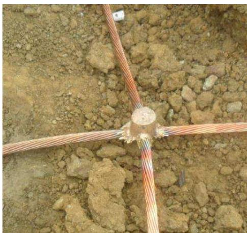
Figura 104 Fotografia da solda exotérmica tipo X.
