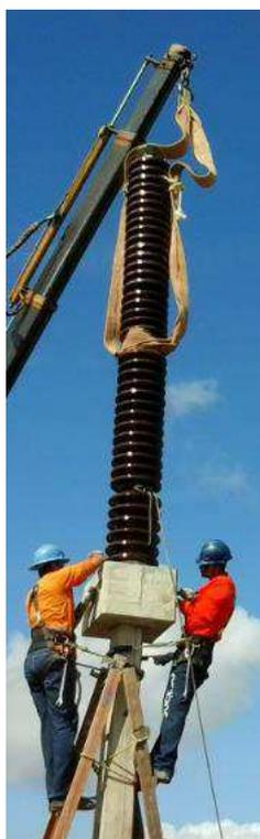
Figura 37. Fotografia da fixação de um IP de 500 kV ao capitel.
