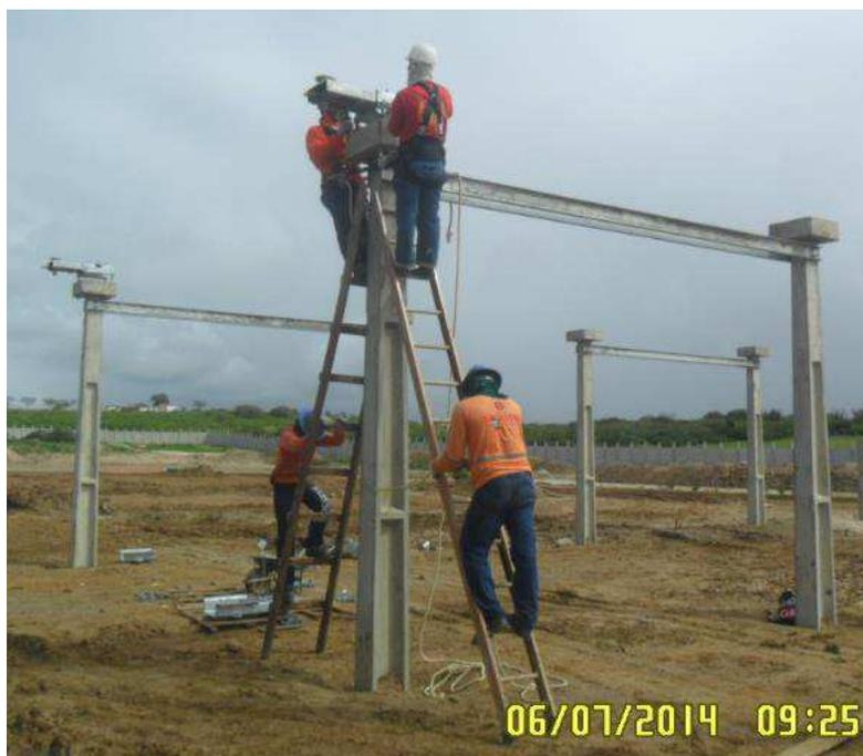
Figura 67. Fotografia da fixação do *chassis* no capitel.
