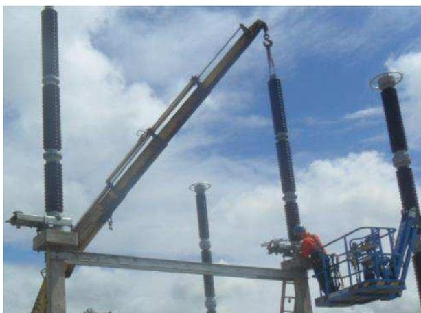
Figura 77. Fotografia da fixação de uma coluna de isoladores em um *chassis*.
