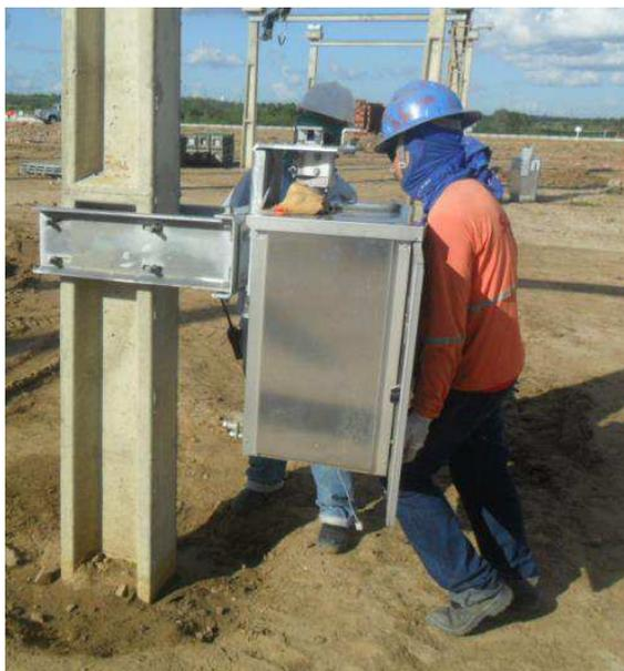
Figura 70. Fotografia da fixação do armário de controle no suporte lateral.
