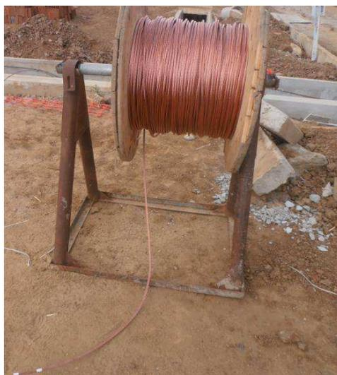
Figura 89. Fotografia da bobina de cabo de cobre nu 50 mm<sup>2</sup>.
