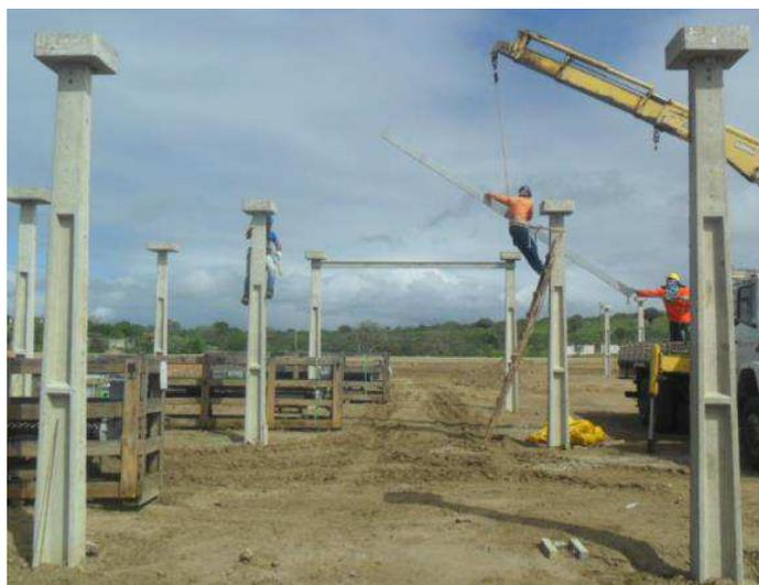
Figura 64. Fotografia da instalação da viga de travamento entre os postes da SPO.
