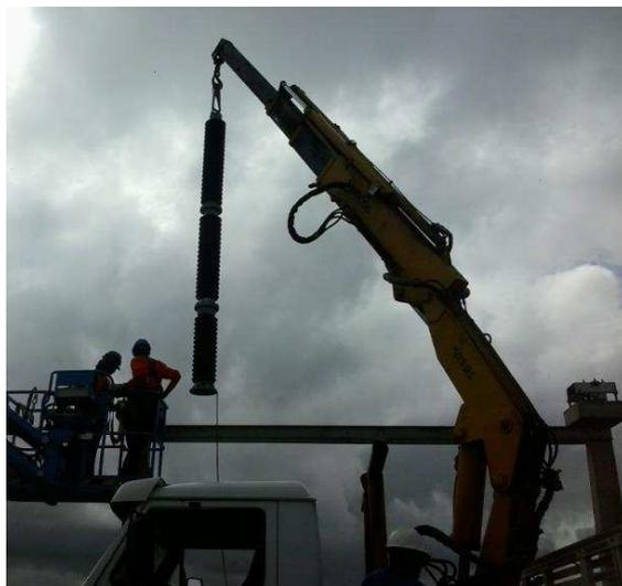
Figura 76. Fotografia do transporte da coluna de isoladores para *chassis*.
