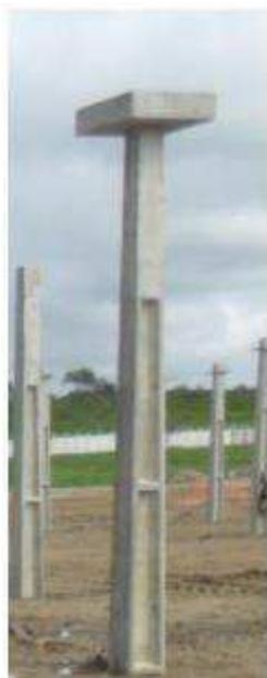
Figura 6. Fotografia de um poste utilizado para o suporte de um TC de 500 kV.
