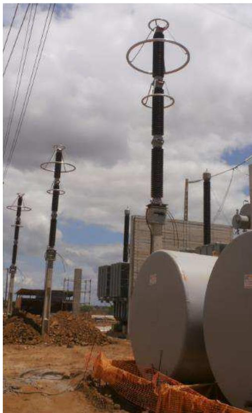
Figura 60. Fotografia dos para-raios de 500 kV utilizados na proteção dos transformadores.
