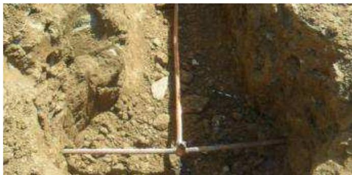
Figura 105. Fotografia da solda exotérmica do tipo T.
