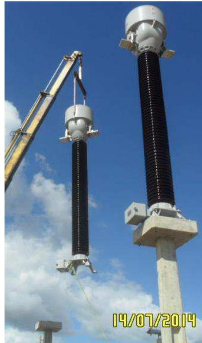
Figura 19. Fotografia de um TC de 500 kV fixado ao poste de suporte.
