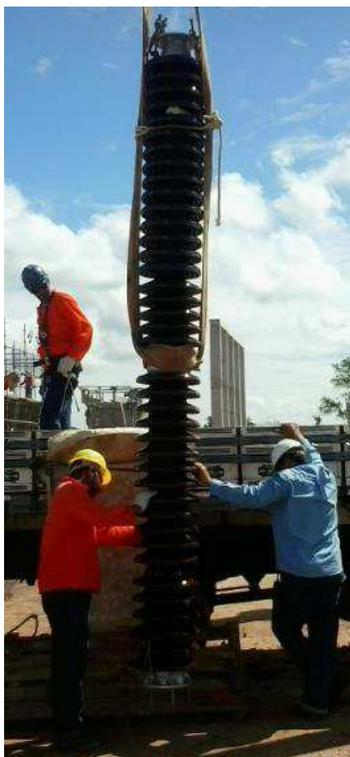
Figura 36. Fotografia da montagem da base com o topo de um IP de 500 kV.
