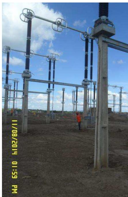
Figura 81. Fotografia da CS SPO com os anéis equalizadores montados.
