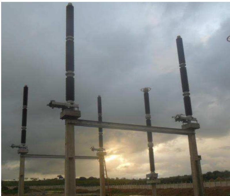
Figura 78. Fotografia de colunas de isoladores fixadas nos *chassis* da CS SPO.
