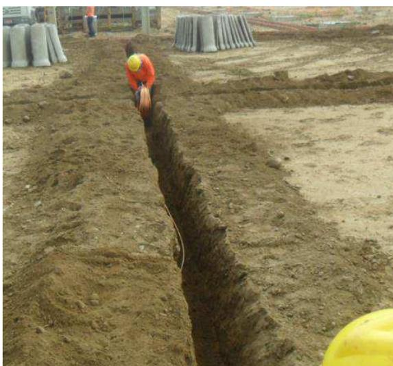
Figura 101. Fotografia do lançamento do cabo de cobre da malha principal.
