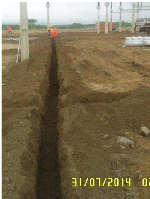
Figura 98. Fotografia de uma vala pronta para receber o cabo da malha de terra principal.
