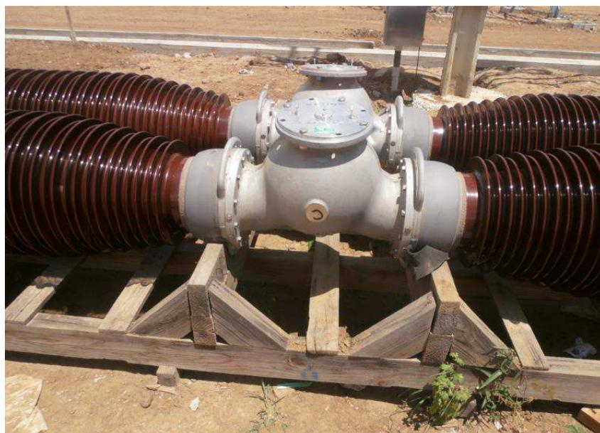
Figura 43. Fotografia das câmaras de extinção de um disjuntor de 500 kV.
