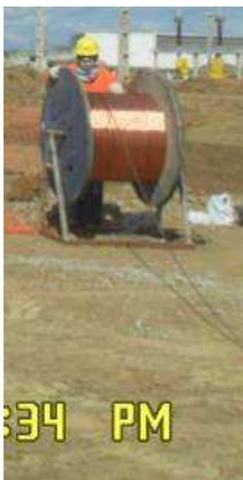
Figura 99. Fotografia do cabo de cobre sendo esticado da bobina.
