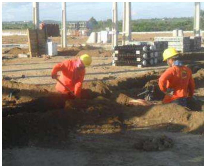
Figura 97. Fotografia do nivelamento das valas para a malha de terra principal.
