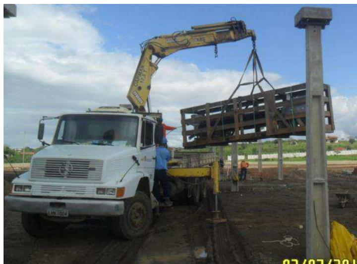
Figura 11. Fotografia de um caminhão *munck* descarregando um TC de 500 kV próximo ao local da montagem.
