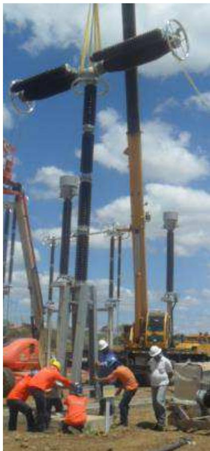
Figura 49. Fotografia da fixação da fase de um disjuntor de 500 kV na base de concreto.
