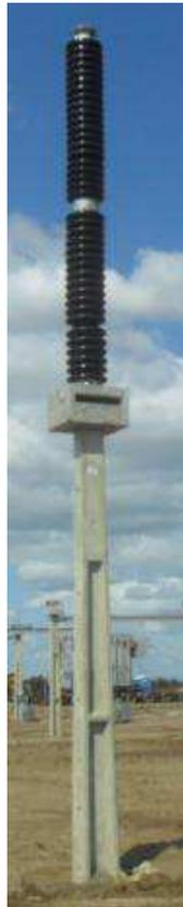
Figura 38. Fotografia de um IP de 500 kV fixado ao poste de suporte.
