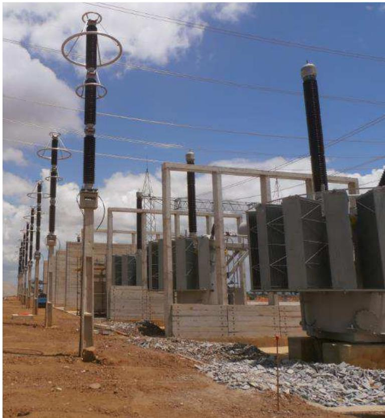
Figura 59. Fotografia dos para-raios de 500 kV utilizados para a proteções dos reatores.
