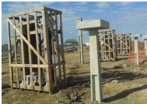
Figura 24. Fotografia da distribuição dos TPC de 500 kV para montagem.
