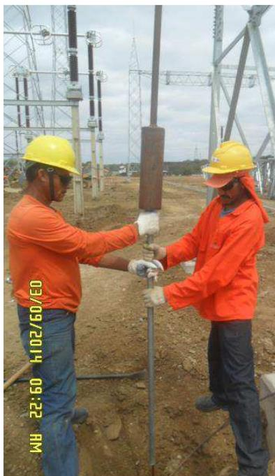
Figura 109. Fotografia da implantação da haste de aterramento.
