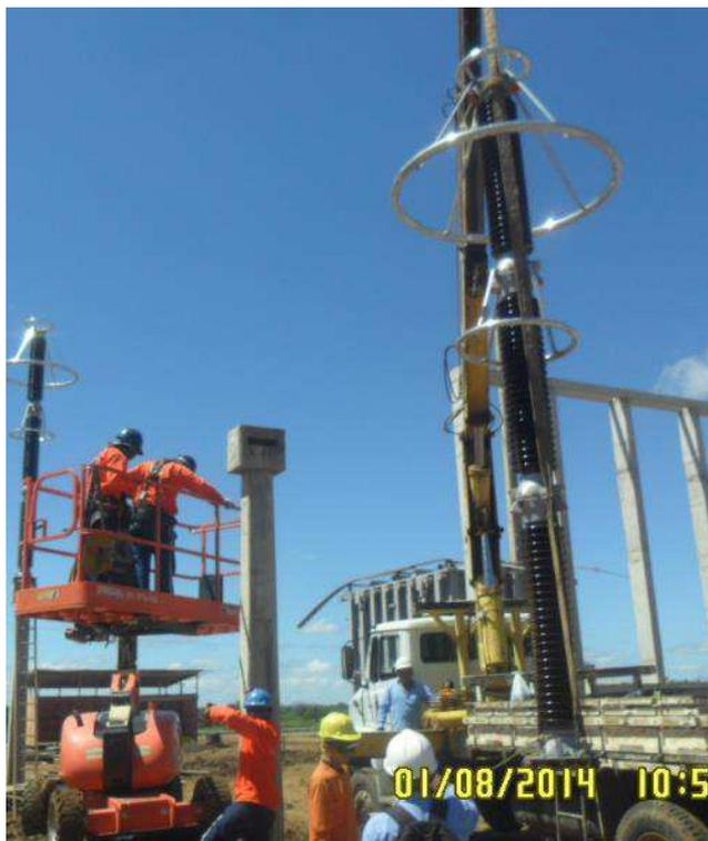
Figura 57. Fotografia do para-raios de 500 kV suspenso pelo caminhão *munck*.
