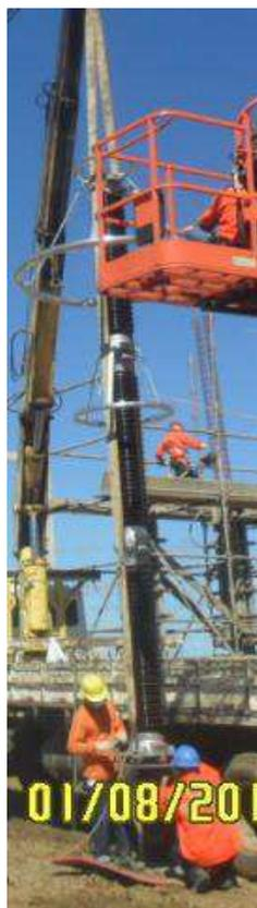
Figura 56. Fotografia da montagem da base com as partes do meio e topo do para-raios de 500 kV.
