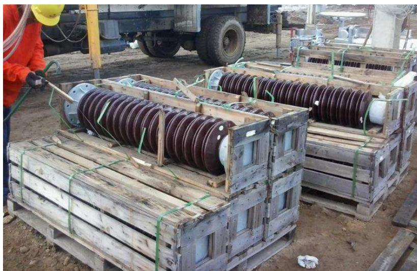
Figura 72. Fotografia dos isoladores das chaves sendo desmontados.
