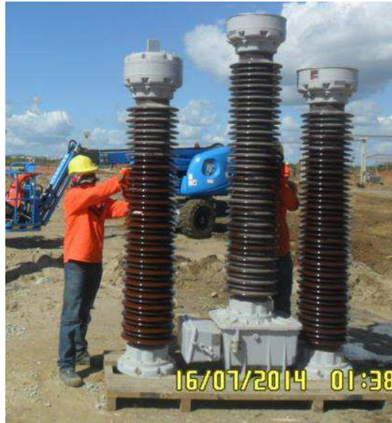
Figura 26. Fotografia da limpeza de um TPC de 500 kV.
