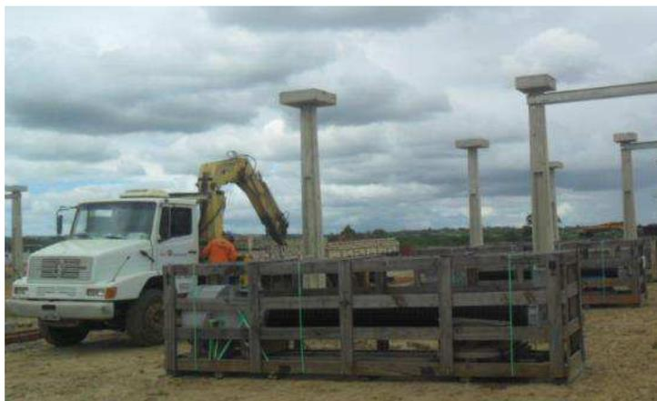
Figura 12. Fotografia de TC de 500 kV distribuídos próximos aos postes para a montagem.
