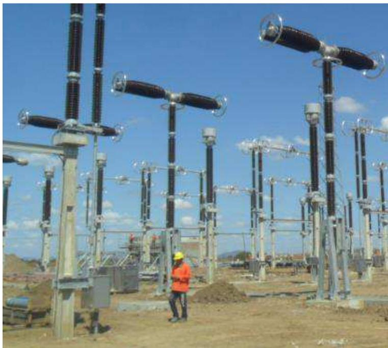
Figura 51. Fotografia de um disjuntor GL317 fixado na base de concreto.
