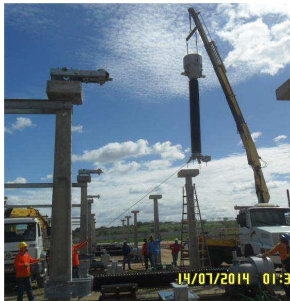
Figura 16. Fotografia de um TC de 500 kV suspenso no ar por um caminhão *munck*.
