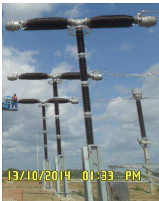
Figura 50. Fotografia de um disjuntor GL317D fixado na base de concreto.
