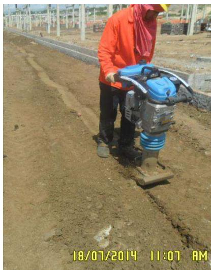
Figura 103. Fotografia da compactação do aterro das valas para a malha de terra principal.
