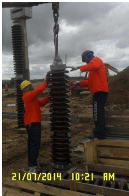
Figura 34. Fotografia da limpeza de um IP de 500 kV.
