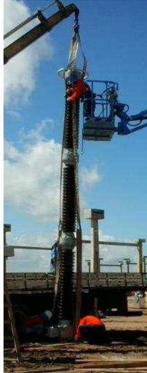
Figura 28. Fotografia da montagem da base com o meio e topo de um TPC de 500 kV.
