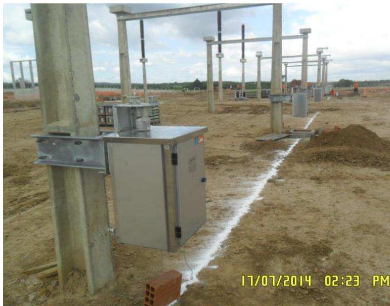
Figura 71. Fotografia de armários de controle fixados nos postes das CS.
