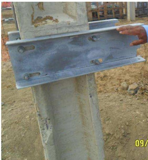
Figura 69. Fotografia do suporte lateral para o armário de controle da chave SPO.
