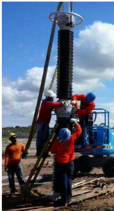
Figura 27. Fotografia da montagem do meio com o topo de um TPC de 500kV.
