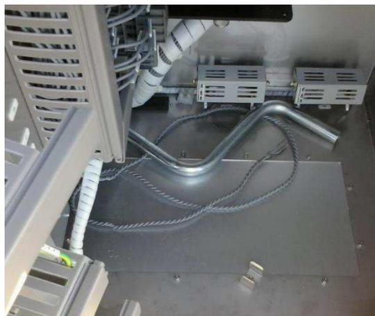
Figura 84. Fotografia da manivela localizada no interior do armário de controle da CS SPO.
