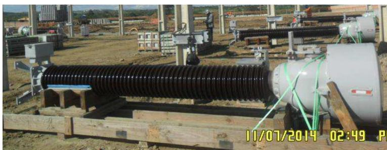
Figura 13. Fotografia de um TC de 500 kV desembalado e limpo.
