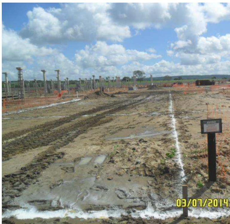
Figura 95. Fotografia da marcação para escavações da malha de terra principal.
