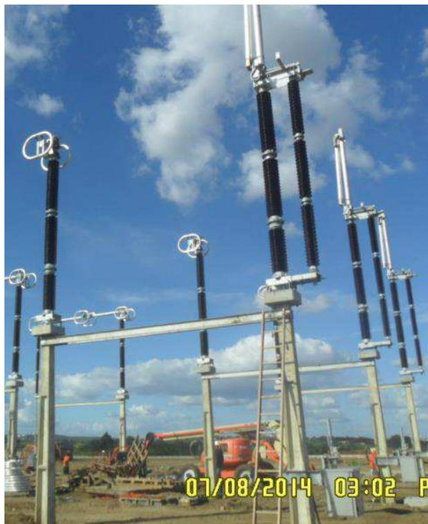
Figura 80. Fotografia de uma CS SPO com a coluna rotativa, terminal de articulação e lança principal montados.
