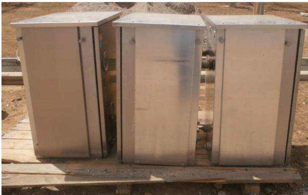
Figura 52. Fotografia dos armários de controle de um disjuntor de 500 kV.
