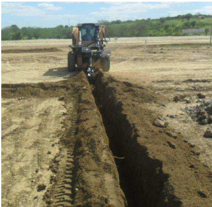
Figura 96. Fotografia da escavação para a malha de terra principal.
