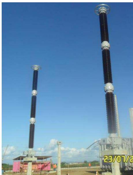
Figura 29. Fotografia de dois TPC de 500 kV fixados no poste de suporte.
