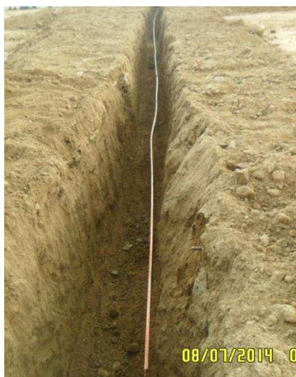
Figura 102. Fotografia do cabo da malha principal lançado.
