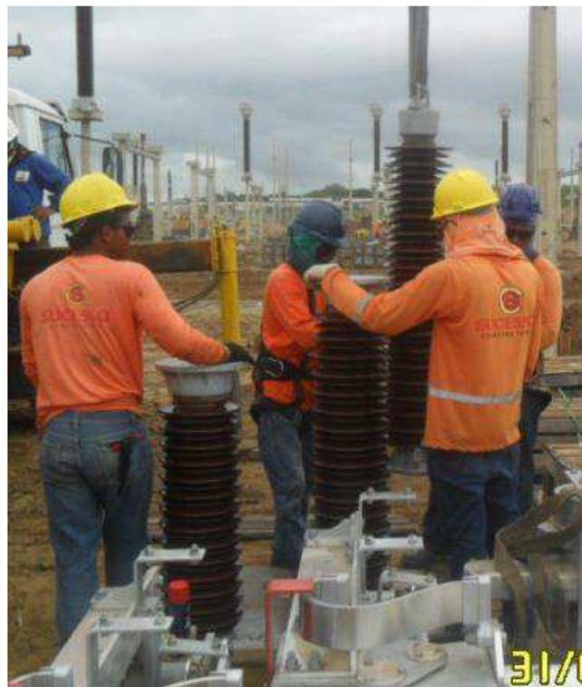
Figura 74. Fotografia do início da montagem da coluna de isoladores para a CS SPO.
