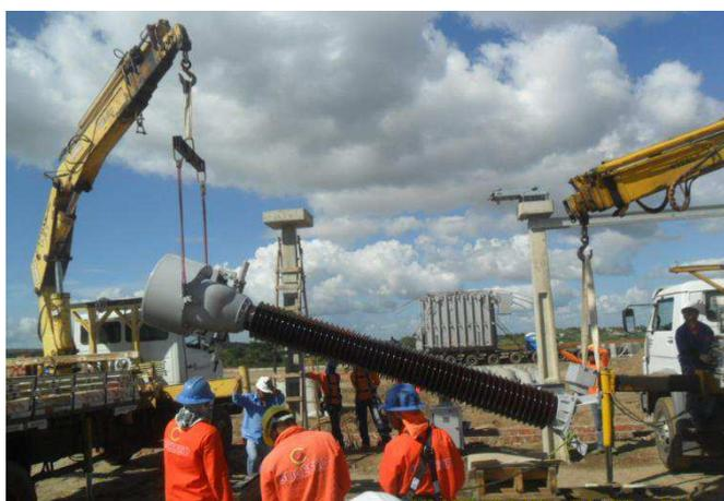
Figura 14. Fotografia de um TC de 500 kV levantado por dois caminhões *munck*.
