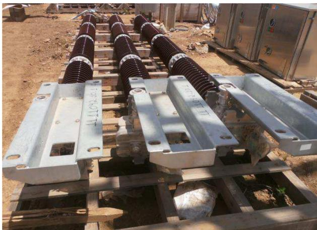
Figura 44. Fotografia das colunas-suporte de um disjuntor de 500 kV.
