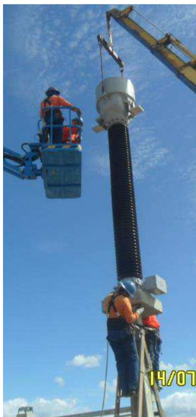
Figura 18. Fotografia de montadores fixando um TC de 500 kV ao poste de suporte.
