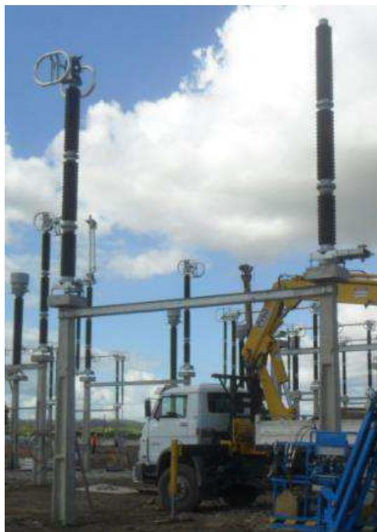
Figura 79. Fotografia de uma coluna de isoladores com terminal de espera instalado.
