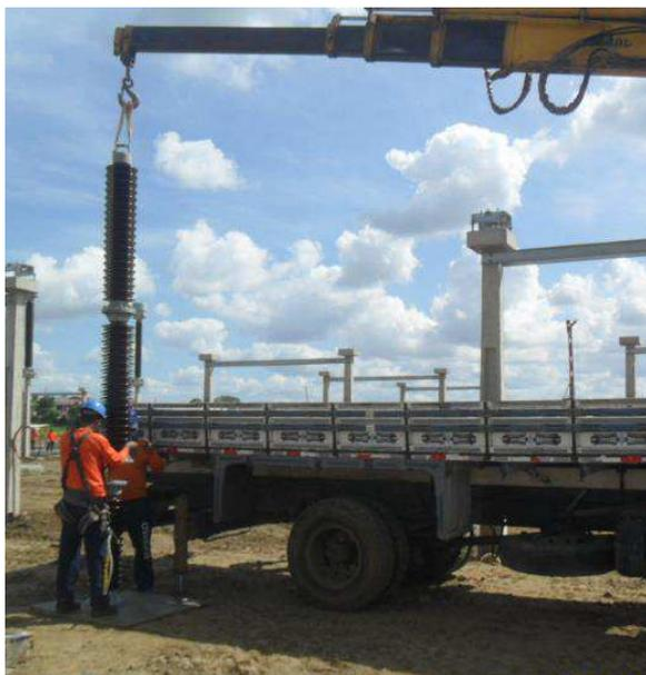
Figura 75. Fotografia da conclusão montagem de uma coluna de isoladores da CS SPO.
