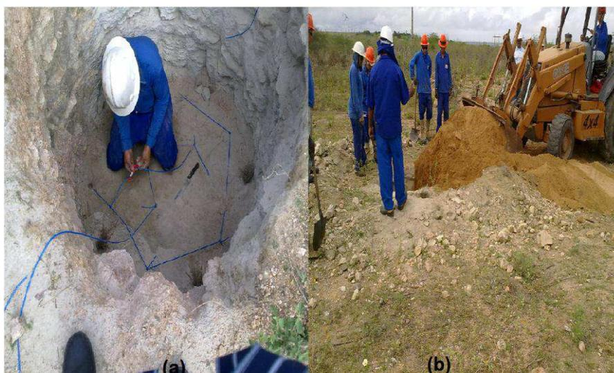
Figura 14 - (a) Fotografia da malha de detonação. (b) Fotografia do abafamento da explosão.
