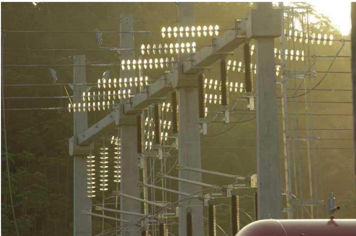
Figura 5 – Entrada da linha de transmissão em uma subestação.
