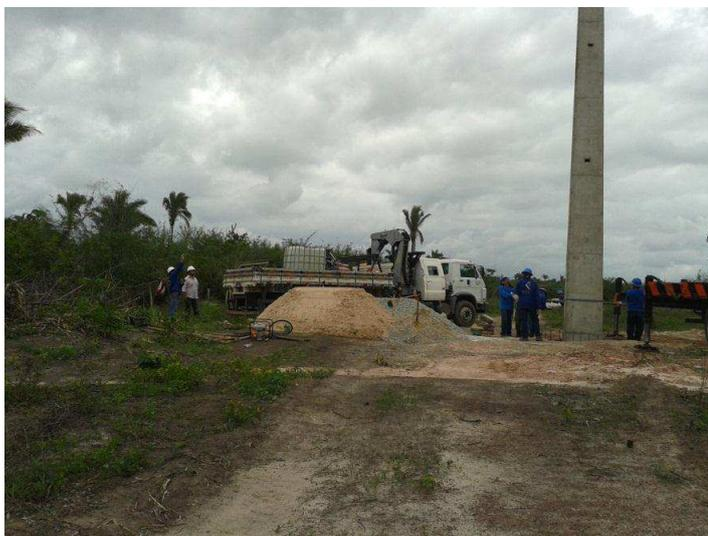
Figura 17 – Poste sendo nivelado através do prumo.
