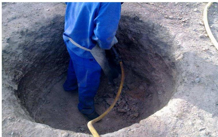
Figura 13 - Fotografia da utilização do rompedor na escavação.
