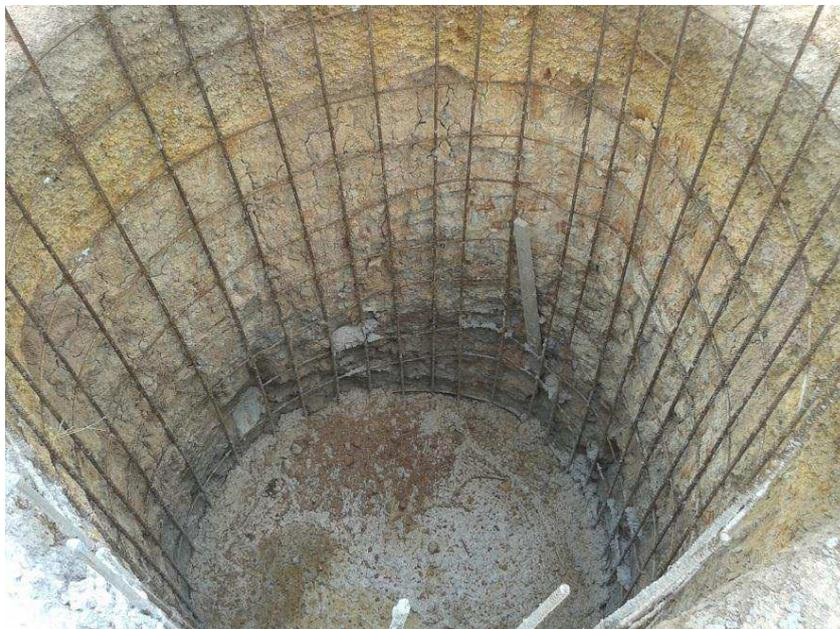
Figura 15 – Ferragem utilizada numa estrutura de amarração, com a sub-base já pronta. Obra: LT 69kV Itapecuru – Rosário.
