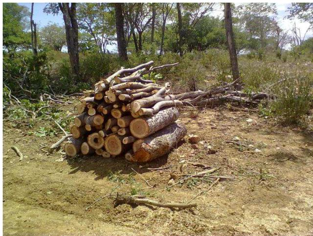
Figura 12 – Empilhamento do material lenhoso durante abertura e limpeza de faixa. Obra: LT 138kV Ibicoara – Porto Alegre/BA.
