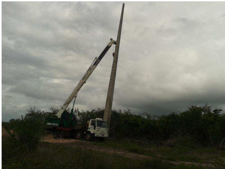
Figura 16 – Implantação de poste com auxílio do guindauto. Obra: LT 69 kV Itapecuru – Rosário/MA.
