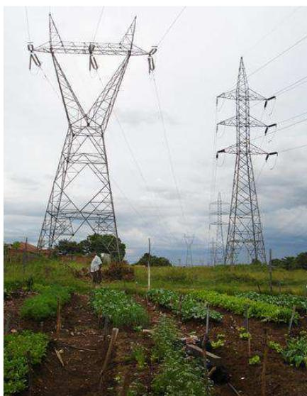
**FIGURA 27 LINHAS DE TRANSMISSÃO DE 230 kV COM ESTRUTURAS METÁLICAS PROXIMO À SE MOSSRO II**
