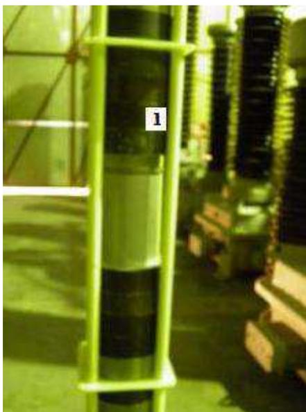
Figura 4.2 Pastilhas de varistores (1) degradadas e em boas condições.
