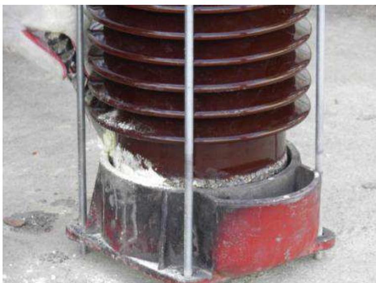
Figura 4.6 Processo de vedação da parte inferior com enxofre.
