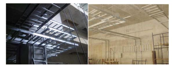
Figura 11 – Leitos para Cabos.
