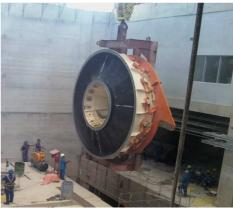
Figura 2- Distribuidor da PCH Queluz-SP.
