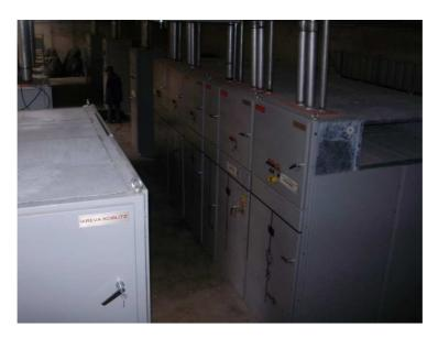
Figura 7 – Painéis de Proteção e Controle
